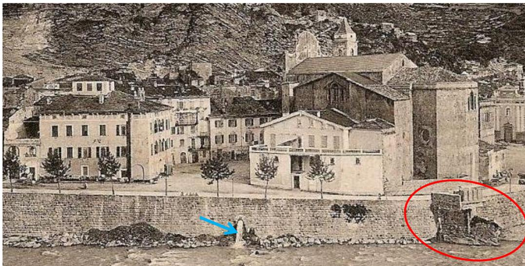
Figure 24. Vue du boulevard Rouvier au début du XXe siècle (Col. Albert Ipert). Postérieure à la photo précédente, on y voit la construction et les remblais réalisés autour du moulin, objets du procès de 1901. Sous la flèche bleue : Exutoire d'eaux de dérivation des eaux en amont du canal du moulin lorsqu'il était à l'arrêt, montrant un fort débit. Dans l'ellipse rouge : Vestige de la digue présente sur les plans de 1692 à 1864 et englobée-réduite dans l'élargissement du virage en 1985.
