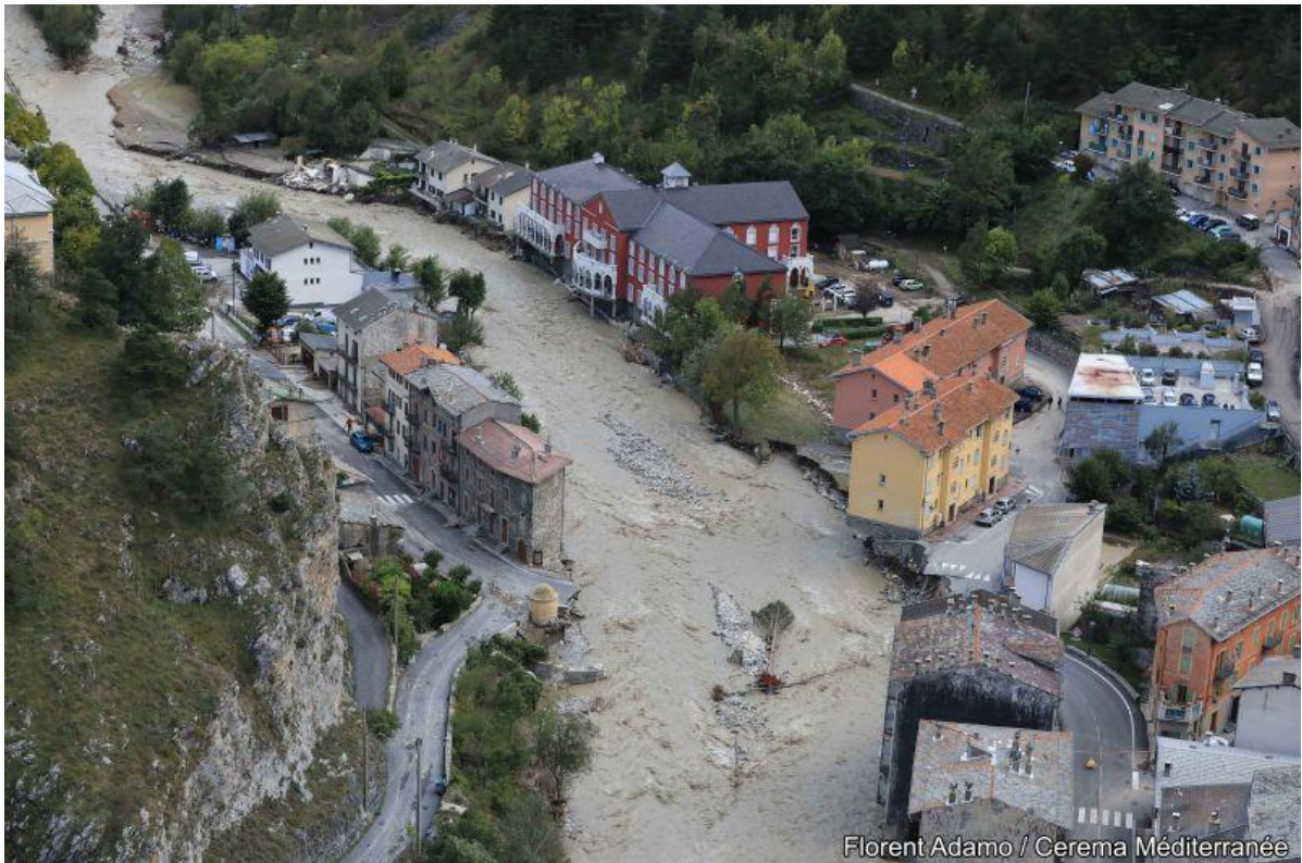
▲ Photo 38 : Engrèvement, destruction du pont av. Georges Bidault, affouillement des fondations. Affouillement des fondations de l'EHPAD (bâtiment rouge en rive droite) Cliché : F. ADAMO, CEREMA. Localisation : cf. Figure 86, réf. P9
