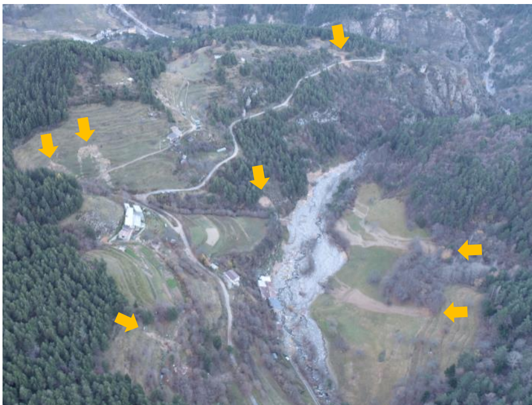
Figure 46 : Glissements superficiels et coulées boueuses autour de Canaressse (Source : ONF-RTM, 17-18/11/2020)
