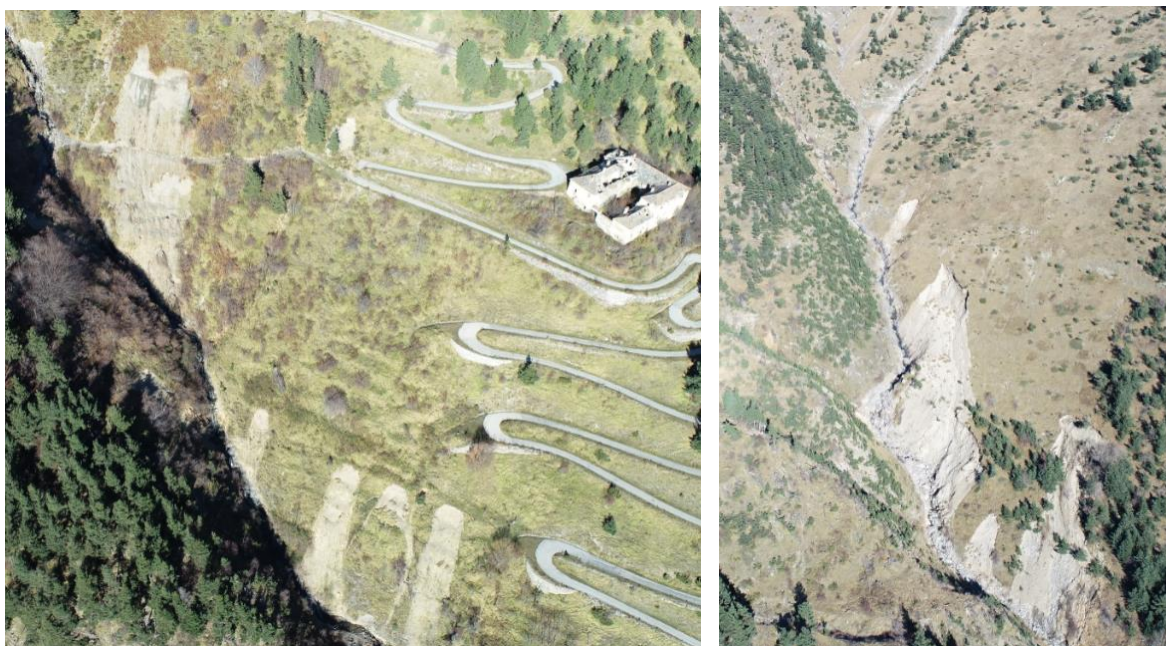
Figure 37 : Petites coulées boueuses affectant les versants du vallon de Mourgon ; glissements plus importants dans le vallon de Cannelle en amont du tunnel
