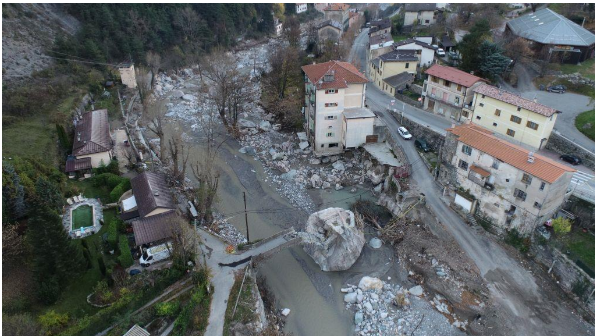
▲ Photo 45 : Pont route de Ste-Anne détruit. Cliché : ONF-RTM Localisation : cf. Figure 94 réf. P2
