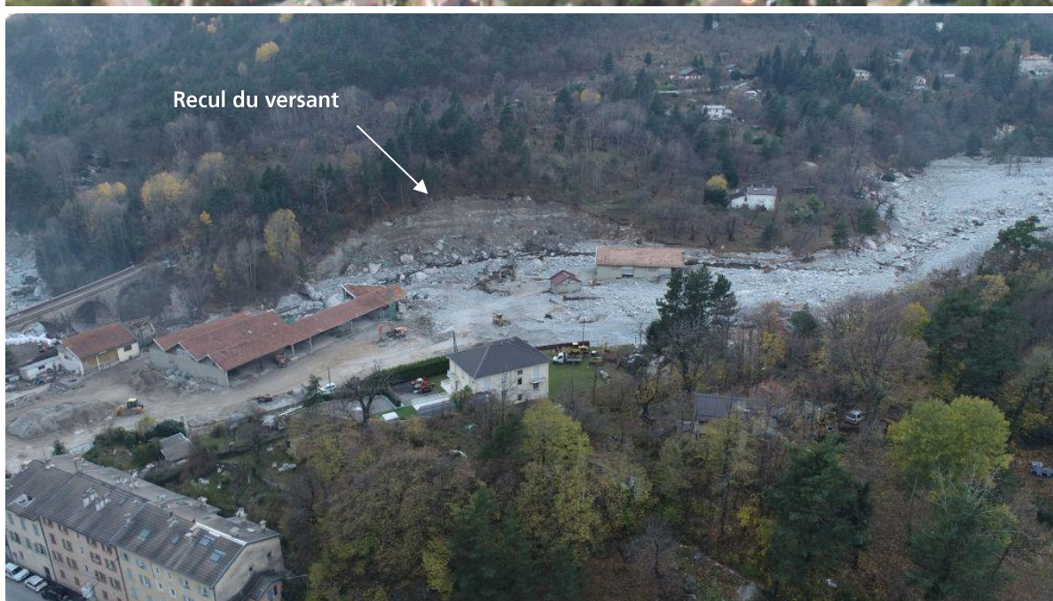
▲ Photo 54 et Photo 55 : Lit de la Bieugne sur son cône de déjection.
