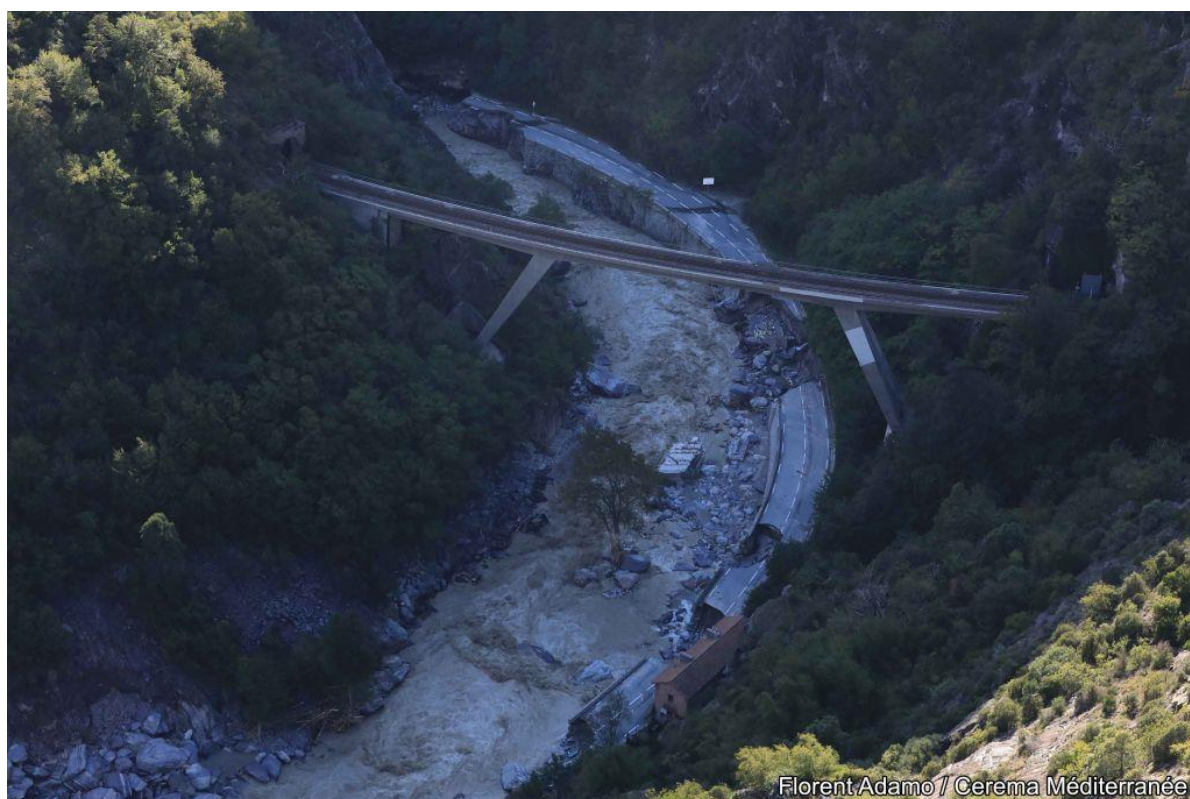
▲ Photo 59 : Roya en amont du viaduc de la voie ferrée (confluence vallon de Berghe). Coupure de route en rive droite. Vue amont -> aval. Cliché : F. ADAMO, CEREMA. Localisation : cf. Figure 100, réf. P0
