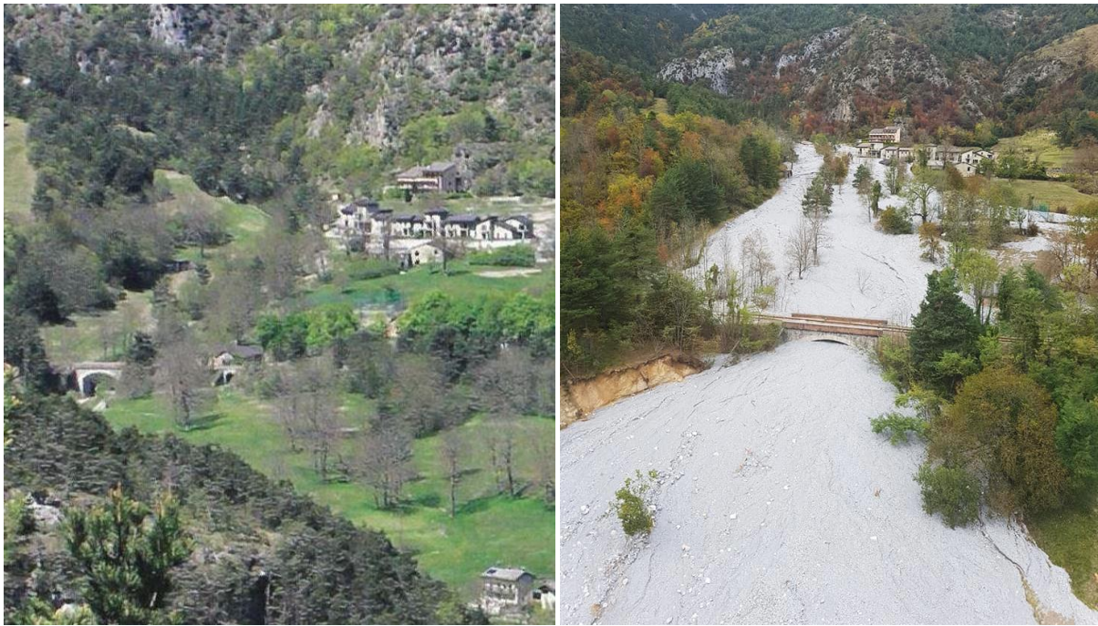
▲ Photo 30 et Photo 31 : Cône de déjection engravé –pont SNCF. Gauche : avant crue. Source ONF-RTM. / Droite : 13/10/2020. Source : ONF-RTM
