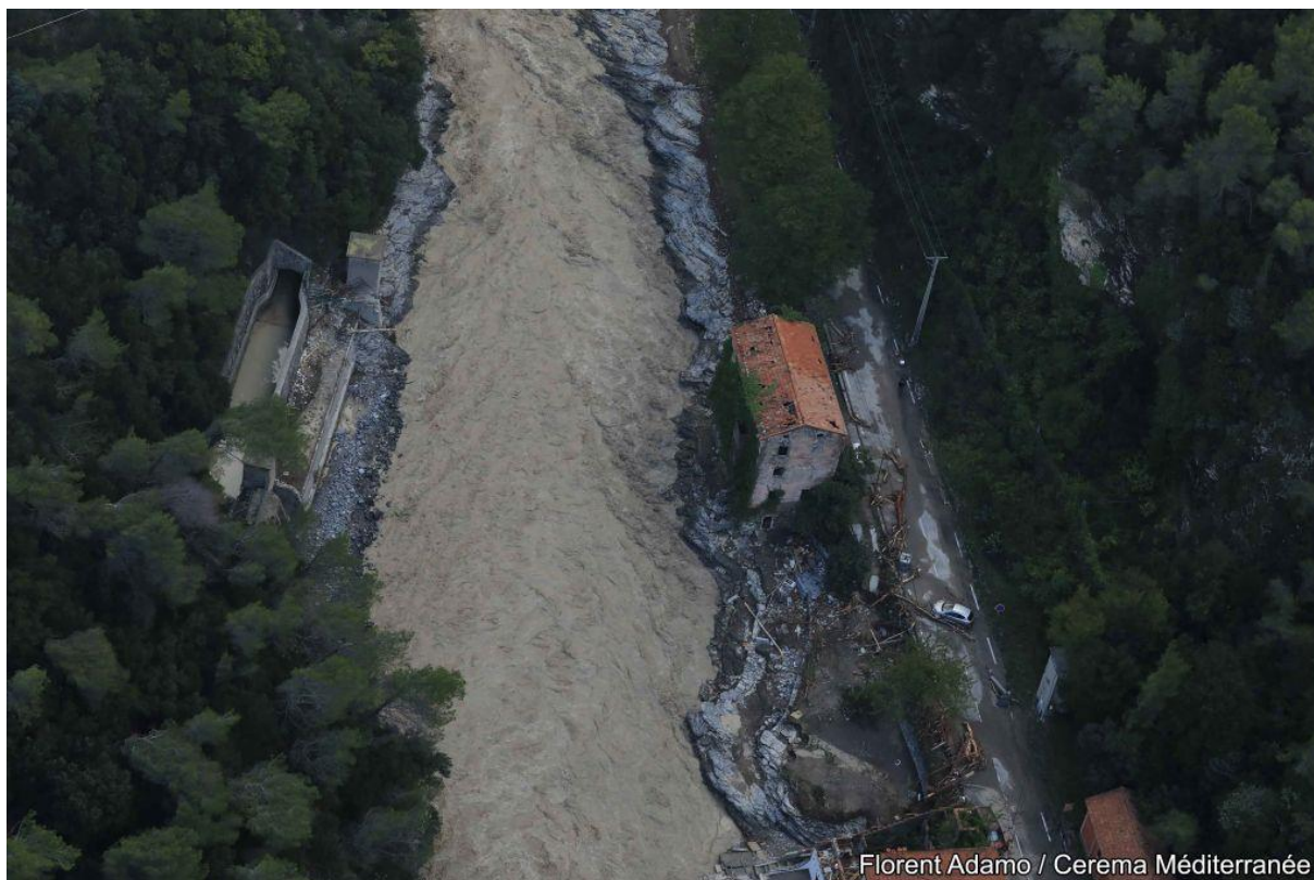
▲ Photo 108 : Roya en aval de Breil sur Roya. Aval de l’Huilerie Cliché : F. ADAMO, CEREMA. Localisation : cf. Figure 108, réf. P5
