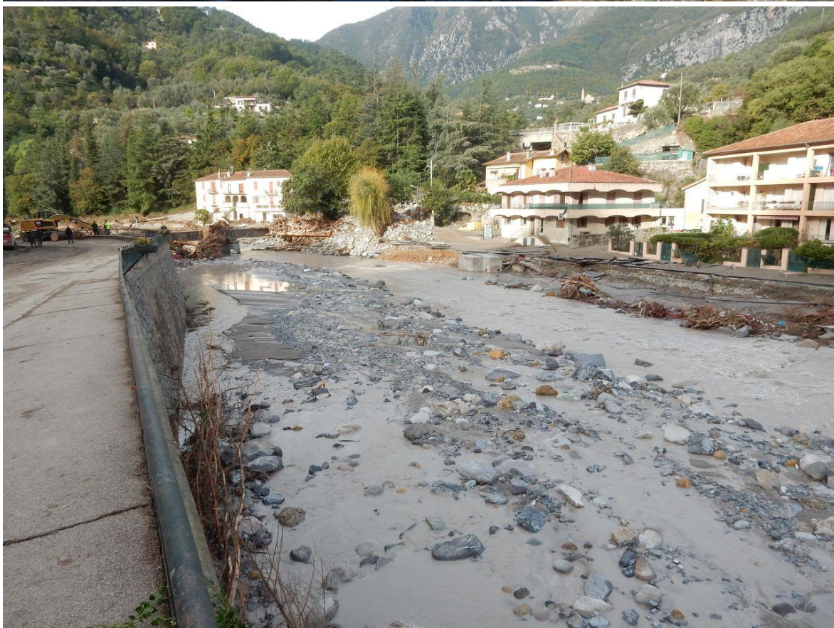
▲ Photo 91 (haut) et Photo 92 (bas) : Roya en amont du Pont Charabot Haut : 2014. Cliché RTM / Bas : 06/10/2020. Cliché RTM
