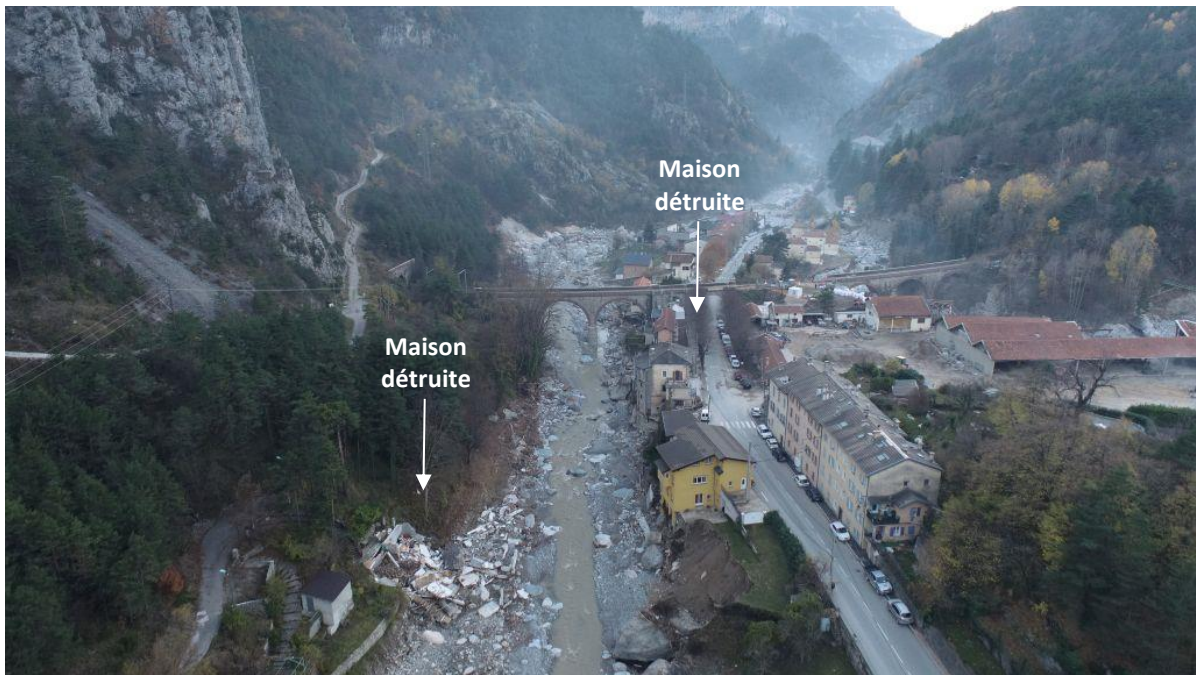
▲ Photo 47 : Lit de la Roya au droit de l'Eglise de St-Dalmas. 2 maisons détruites. Vue amont -> aval Cliché : ONF-RTM. Localisation : cf. Figure 94 ref. P4
