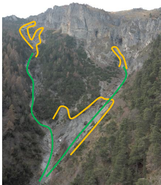
Figure 44 : Partie amont du vallon de Rabay – Éboulis calcaires à matrice argileuse déstabilisés et ravinés (en orange) par les écoulements dans les talwegs (en vert) (Source : ONF-RTM : 17-18/11/2020)
