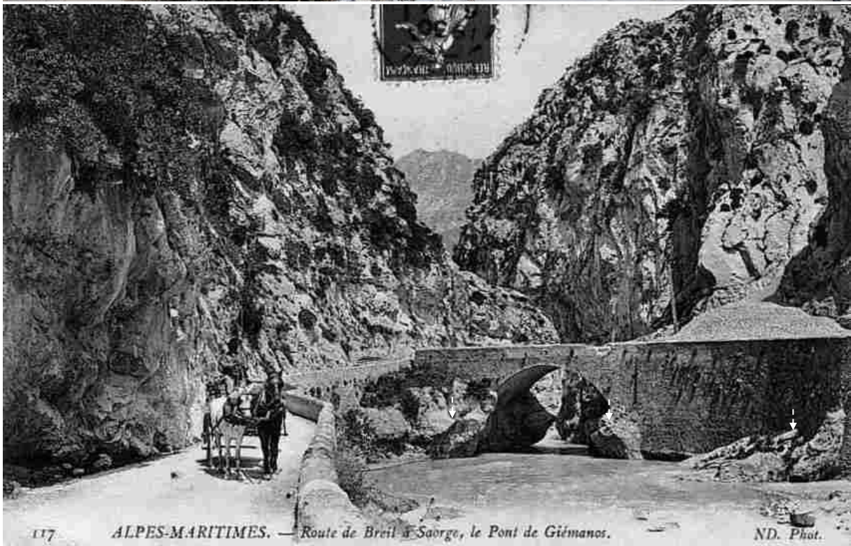
▲ Photo 82 (haut) et Photo 83 (milieu) : Evolution fin XIXème début XXème vs 10/2020 – vue vers l’amont Bas : carte postale non datée du pont de Giémanos / Haut : photo post crue 13/10/2020 (ONF-RTM) A noter contour jaune : vestige de pile rive gauche du pont visible sur carte postale ancienne. Flèches blanches : points de repères identiques sur les 2 clichés. Le niveau post crue Alex est supérieur au niveau de fond de lit ancien. En atteste aussi le découvrement de la fondation du mur rive gauche en aval du pont
