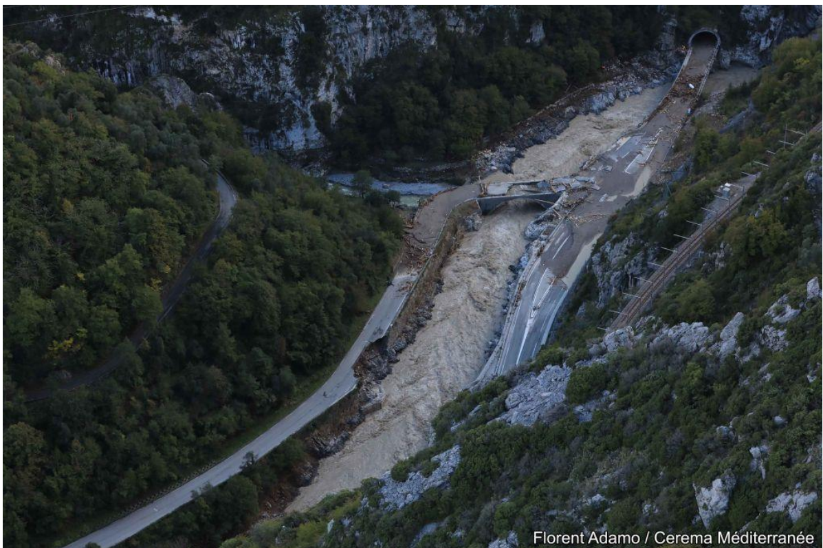
▲ Photo 79 : Roya entre les deux tunnels. Pont de Saorge submergé par les écoulements. Dépôt de flottants en amont de l'entrée du second tunnel. Traces d'écoulements dans le second tunnel. Vue amont -> aval. Cliché : F. ADAMO, CEREMA. Localisation : cf. Figure 104, ref. P1
