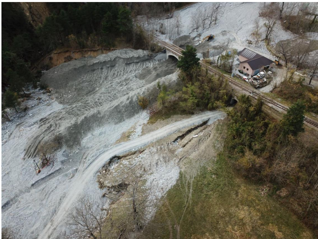
▲ Photo 32 : Pont SNCF en cours de déblaiement. Source : V. KOULINSKI, 07/11/2020 (localisation cf. Figure 90, ref. P15)
