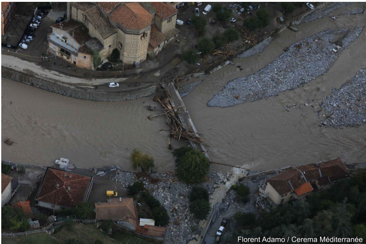
▲ Photo 89 : Roya au droit du pont Charabot obstrué par les flottants. Vue amont -> aval. Cliché : F. ADAMO, CEREMA. Localisation : cf. Figure 104, réf. P8
