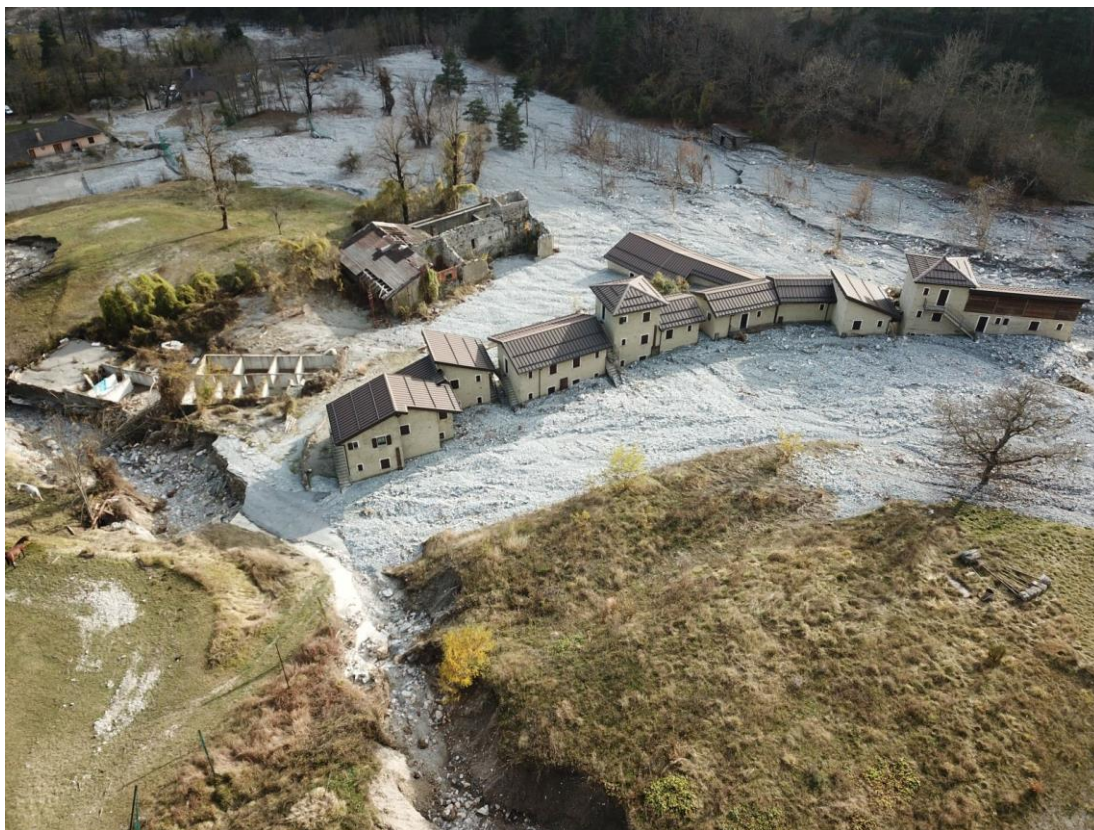
▲ Photo 28 : Vue par l'amont des bâtiments du centre de vacances. Source : V. KOULINSKI, 07/11/2020 (localisation cf. Figure 90, réf. P8)
