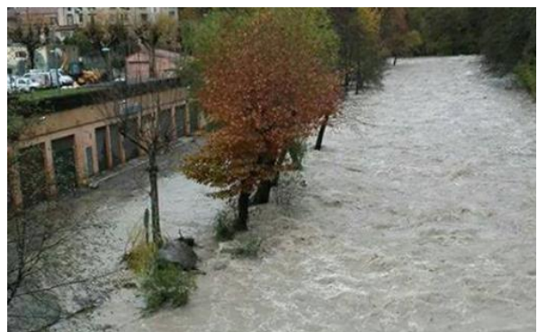
▲ Photo 11 : Crue du 23/11/2016. Breil-sur-Roya en amont du pont Supérieur. Inondation des Services techniques. Source : RTM
