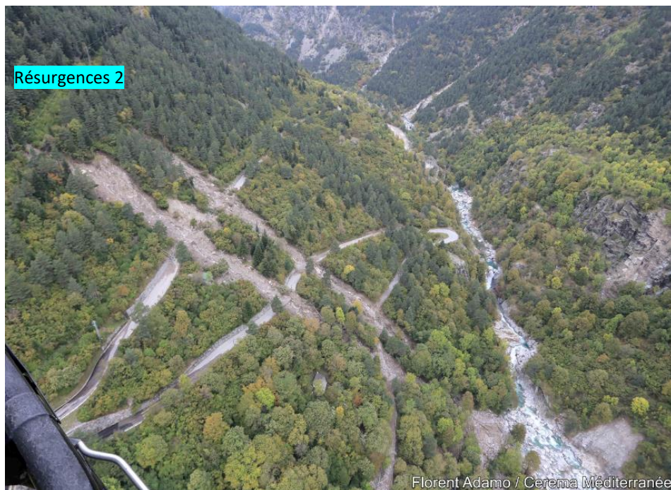
Figure 61 : Coulées Est en rive gauche (Source : F. Adamo, CEREMA)
