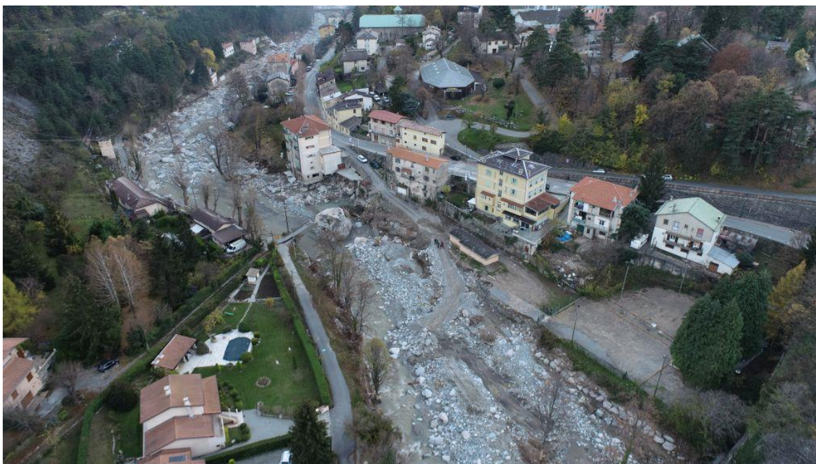
▲ Photo 43 : Pont route de Ste-Anne détruit. Cliché : ONF-RTM Localisation : cf. Figure 94 ref. P0
