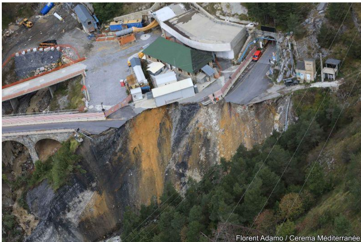
▲ Photo 13 : Glissement survenu en aval du tunnel de Tende (localisation cf. Figure 86 réf. P0 Tende)
