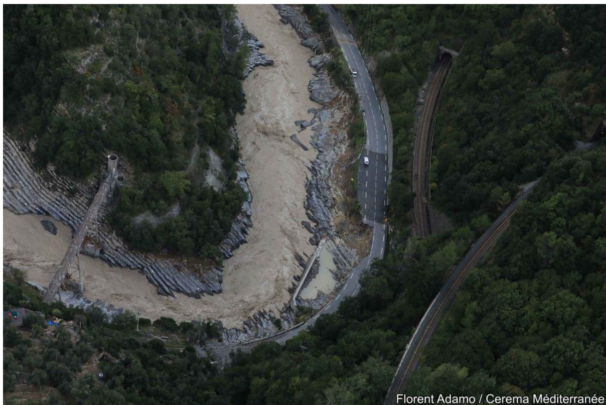
▲ Photo 104 : Roya en aval de Breil sur Roya. Entre Vanne EDF et rejet des conduites de dérivation Cliché : F. ADAMO, CEREMA. Localisation : cf. Figure 108, ref. P1
