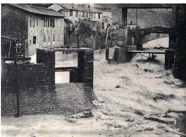
▲ Photo 3 : Crue du 21/11/1926. La Roya en crue a submergé le chantier du barrage de Breil. Source : Archives RTM – Photocopie d'extrait d'ouvrage – réf. inconnue
