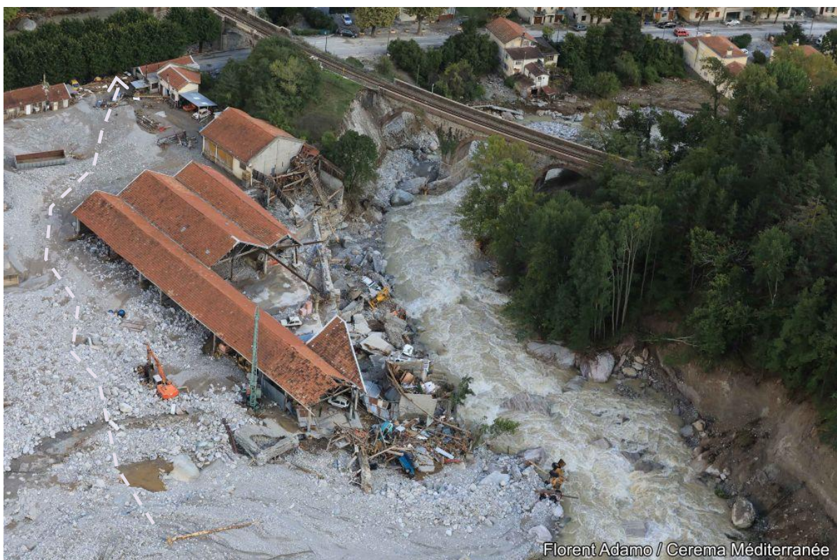
▲ Photo 57 : Hangars engravés et partiellement détruits en amont du viaduc de la voie ferrée. Divagations en rive gauche ayant rejoint la Roya. Cliché : F. ADAMO (CEREMA). Localisation : cf. Figure 98 réf. P3
