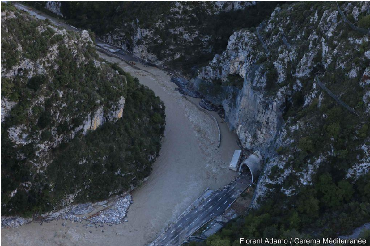
▲ Photo 78 : Roya au droit de l'entrée du tunnel amont de Saorge. Ecoulements dans le tunnel. Erosion de la route au droit de l'entrée. Vue amont -> aval. Cliché : F. ADAMO, CEREMA. Localisation : cf. Figure 104, ref. P0
