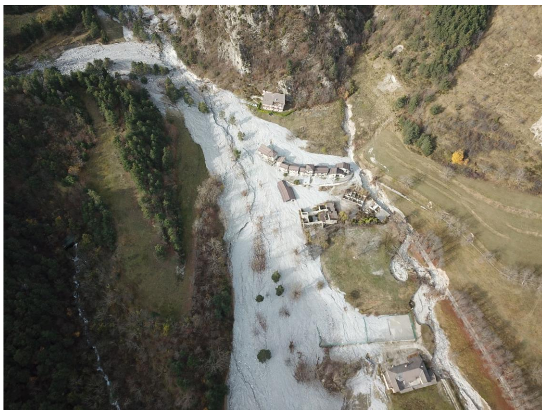
▲ Photo 29 : Cône de déjection engravé – Amont du pont SNCF. Source : V. KOULINSKI, 07/11/2020 (localisation cf. Figure 90, réf. P13)
