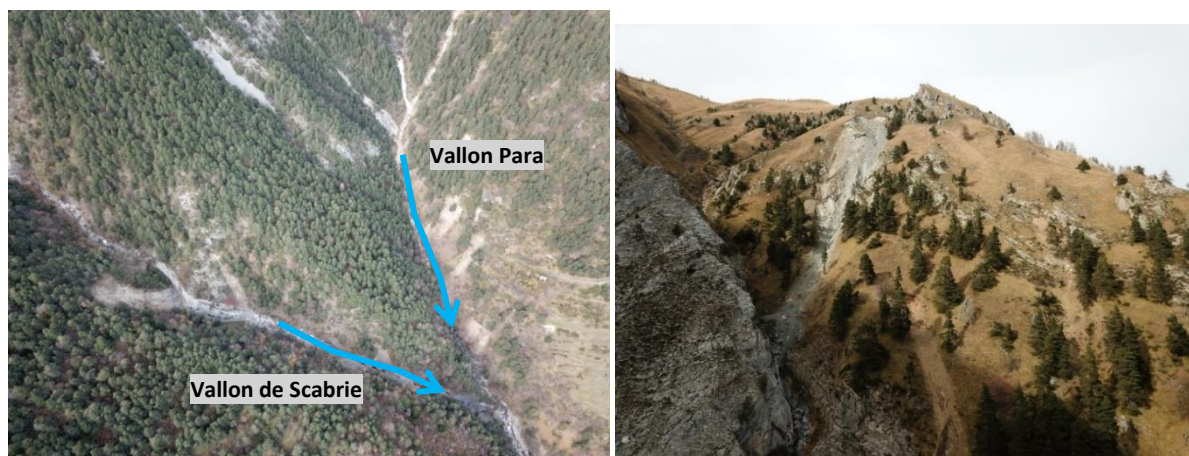
Figure 43 : Glissement dans le vallon de Scabrie (à gauche) et glissement dans le vallon de la Morte (à droite) (Source : ONF-RTM, 17-18/11/2020)
