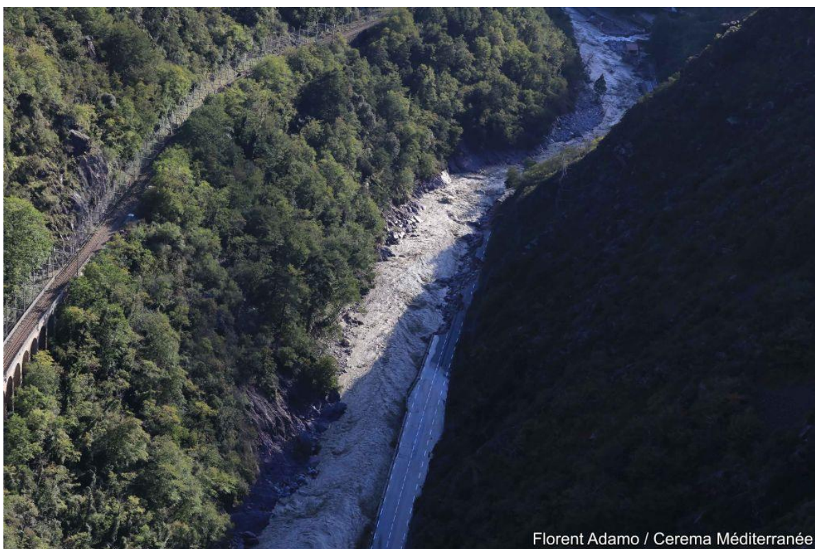
▲ Photo 61 : Roya au niveau des gorges de Berghe. Coupure de route en rive droite Vue amont -> aval Cliché : F. ADAMO, CEREMA. Localisation : cf. Figure 100, réf. P3
