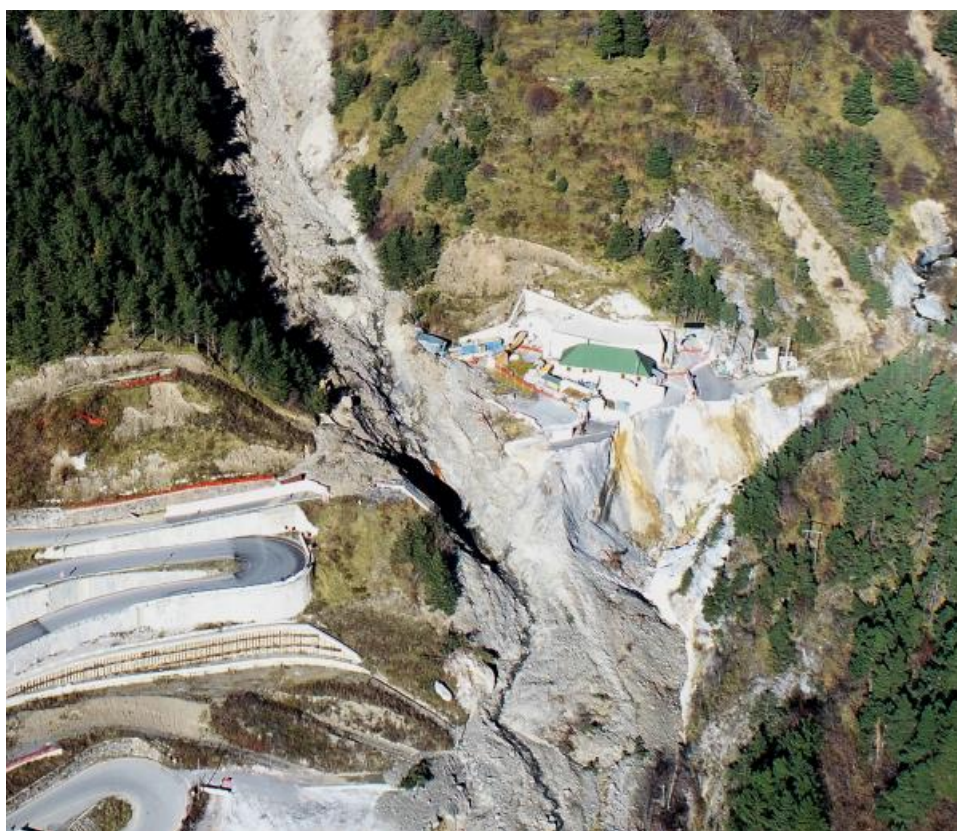
▲ Photo 14 : Photo de l'entrée du tunnel de Tende le 18 nov. (RTM) post glissement (Localisation cf. Figure 86 réf. P0 Tende)
