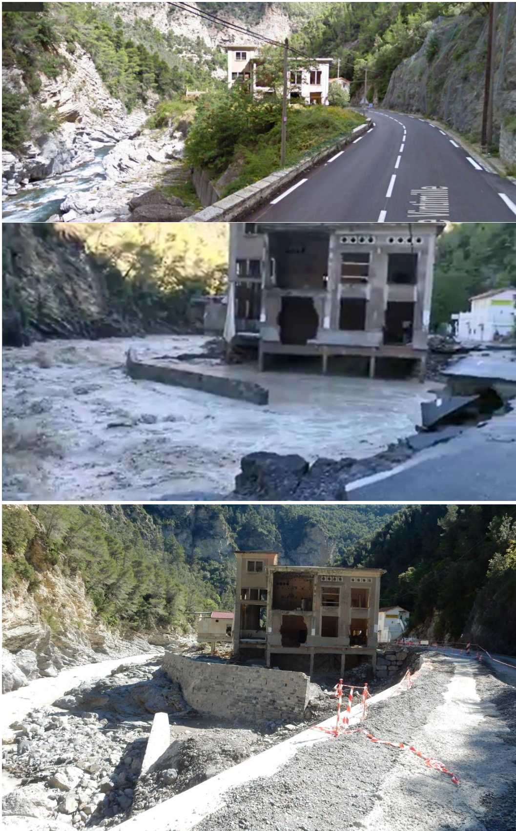
▲ Photo 99 (haut), Photo 100 (milieu), Photo 76 (bas) : Illustration de la remontée des niveaux au droit de Pienne Basse (Huilerie) Haut : capture d'écran Google Street View 2010 - Milieu : capture vidéo 03/10/2021 – Bas : cliché ONF-RTM 05/2021
