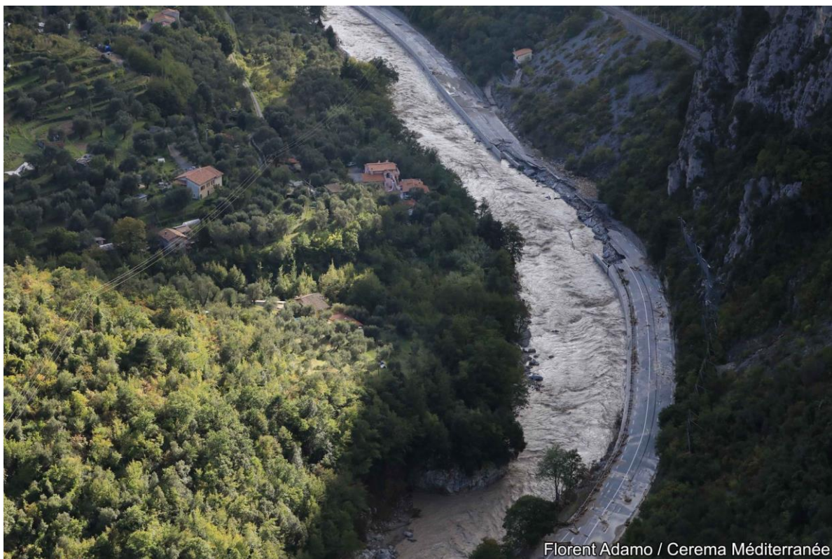
▲ Photo 86 : Roya au droit du hameau de Veil. Coupure de la route en rive droite. Vue amont -> aval. Cliché : F. ADAMO, CEREMA. Localisation : cf. Figure 104, ref. P4
