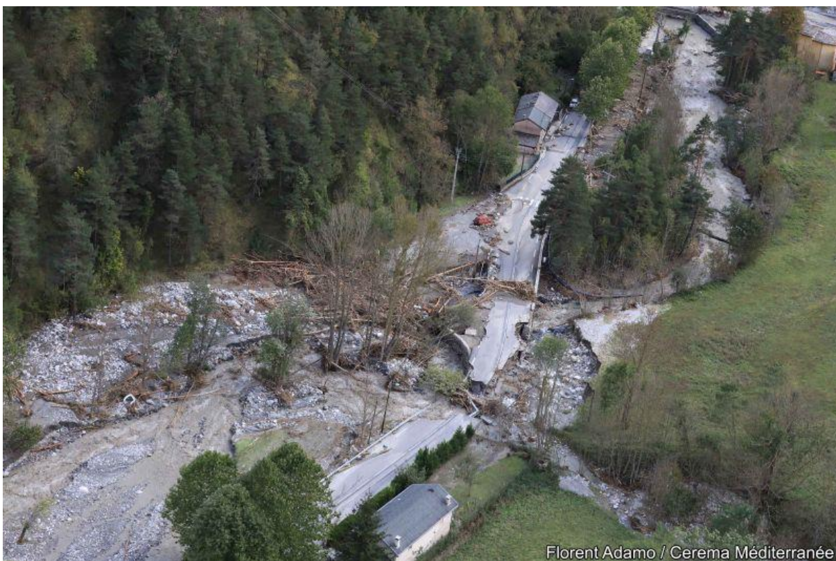
▲ Photo 16 : Pont de la RD 6204 obstrué par les flottants en amont de la confluence avec le torrent de Morte (localisation cf. Figure 86 réf. P2 Tende)
