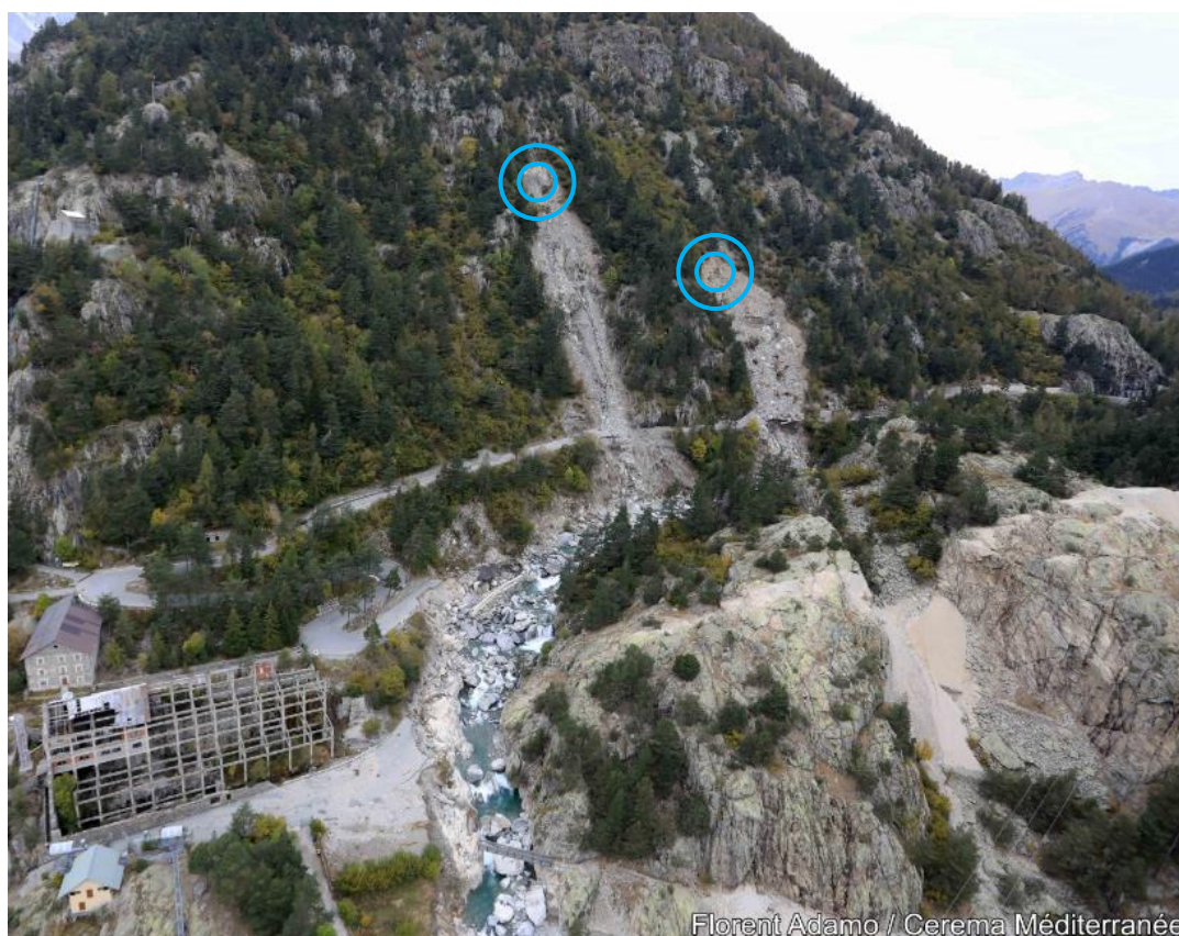
Figure 52 : Glissements de terrains en rive droite du vallon de Casterino, en lien probable avec des sorties d'eau drainant naturellement (karst) et/ou artificiellement (anciennes galeries de mines) le massif de Plan Tendasque (Source : F. Adamo, CEREMA, 09/10/2020)
