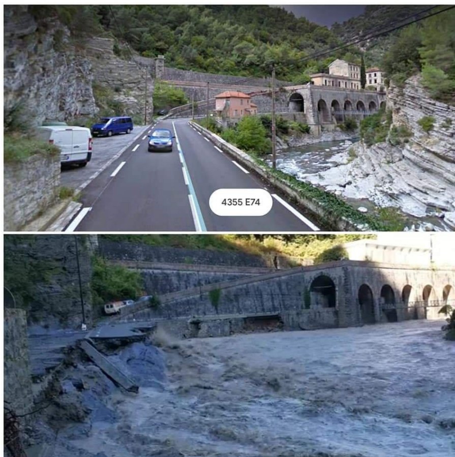
▲ Photo 93 (haut) et Photo 94 (bas) : Illustration de la remontée des niveaux au droit de Piene Basse (Entre Passerelle EDF et huilerie). Haut : google street view 2010 / Bas : capture vidéo 03/10/2020
