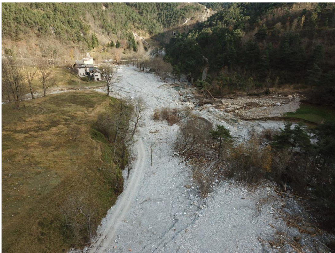
▲ Photo 33 : Tronçon à l'aval du pont SNCF.
