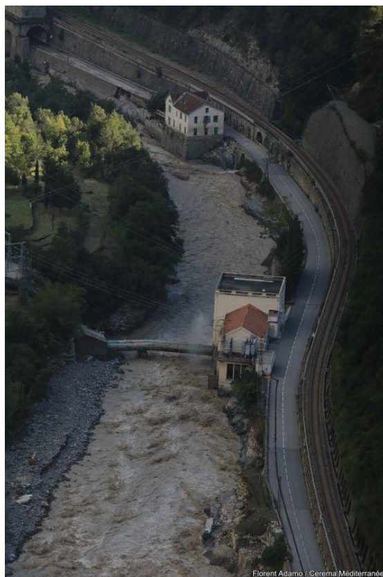
▲ Photo 106 : Roya en aval de Breil sur Roya. Conduite forcée EDF Cliché : F. ADAMO, CEREMA. Localisation : cf. Figure 108, ref. P3
