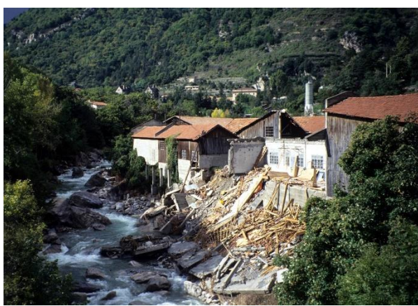
▲ Photo 4 : Crue du 13/09/1993. Destruction de l'entrepôt de l'entreprise Balagayrie à St-Dalmas de Tende. Source : RTM
