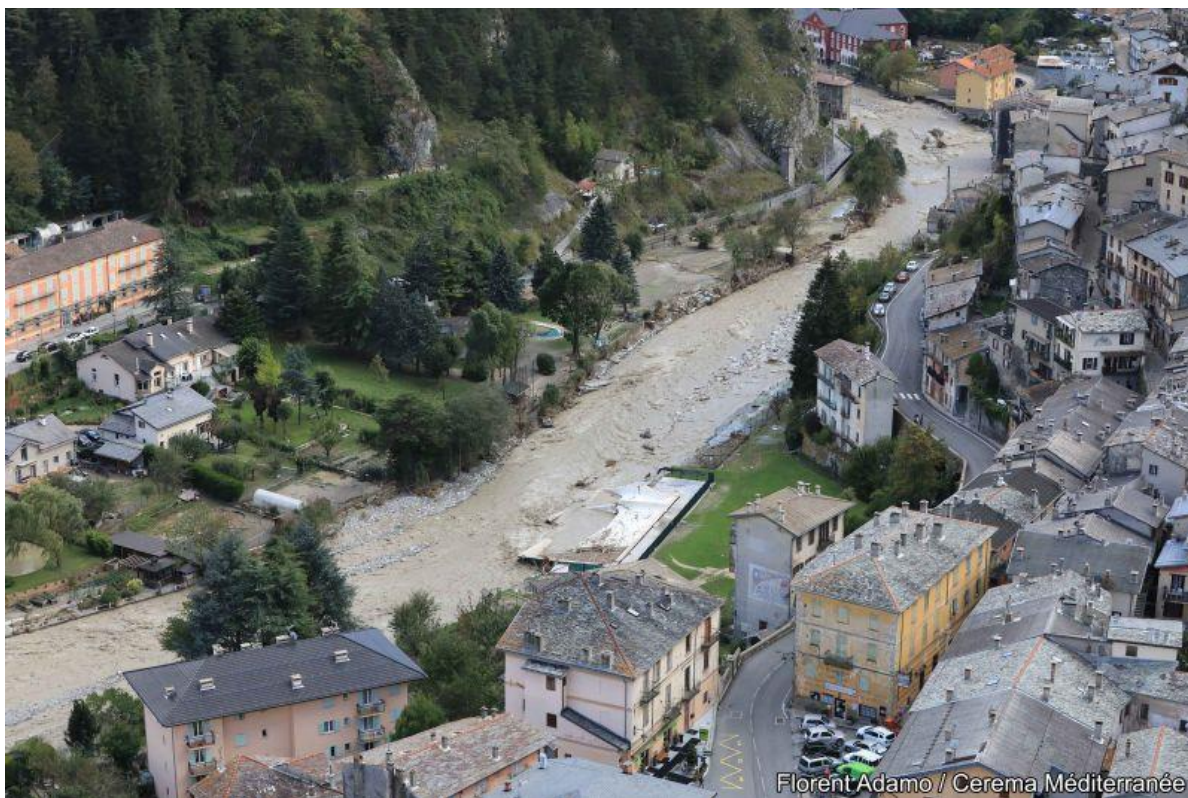
▲ Photo 36 : Engrèvement et submersion de la piscine de Tende. Cliché : F. ADAMO, CEREMA (Localisation cf. Figure 86, réf. P7)
