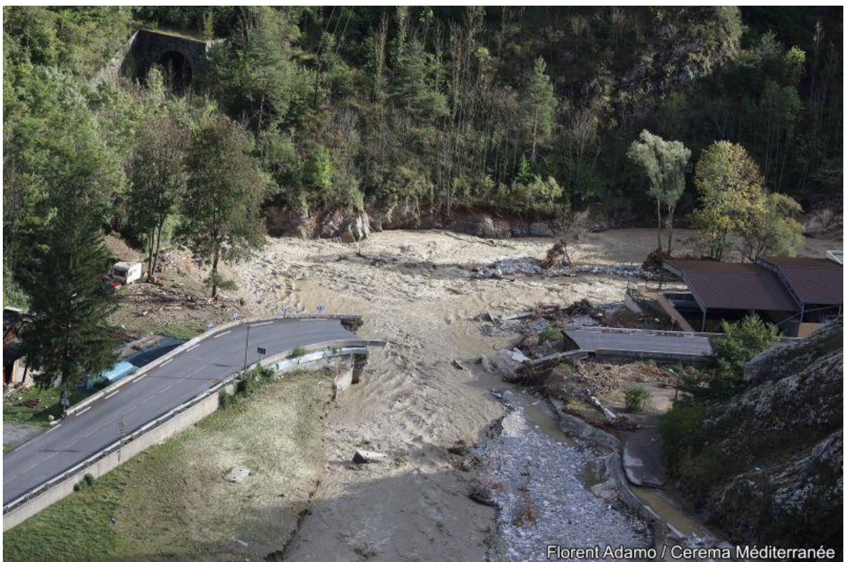
▲ Photo 39 : Pont des 14 Arches détruit. Cliché : F. ADAMO, CEREMA. Localisation cf. Figure 86, réf. P10
