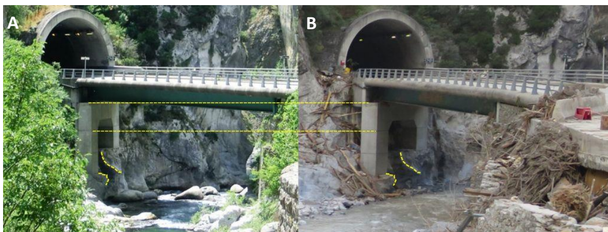
▲ Photo 76 (A) et Photo 77 (B) : Comparaison de niveaux de fond de lit d'après photos terrestres.
