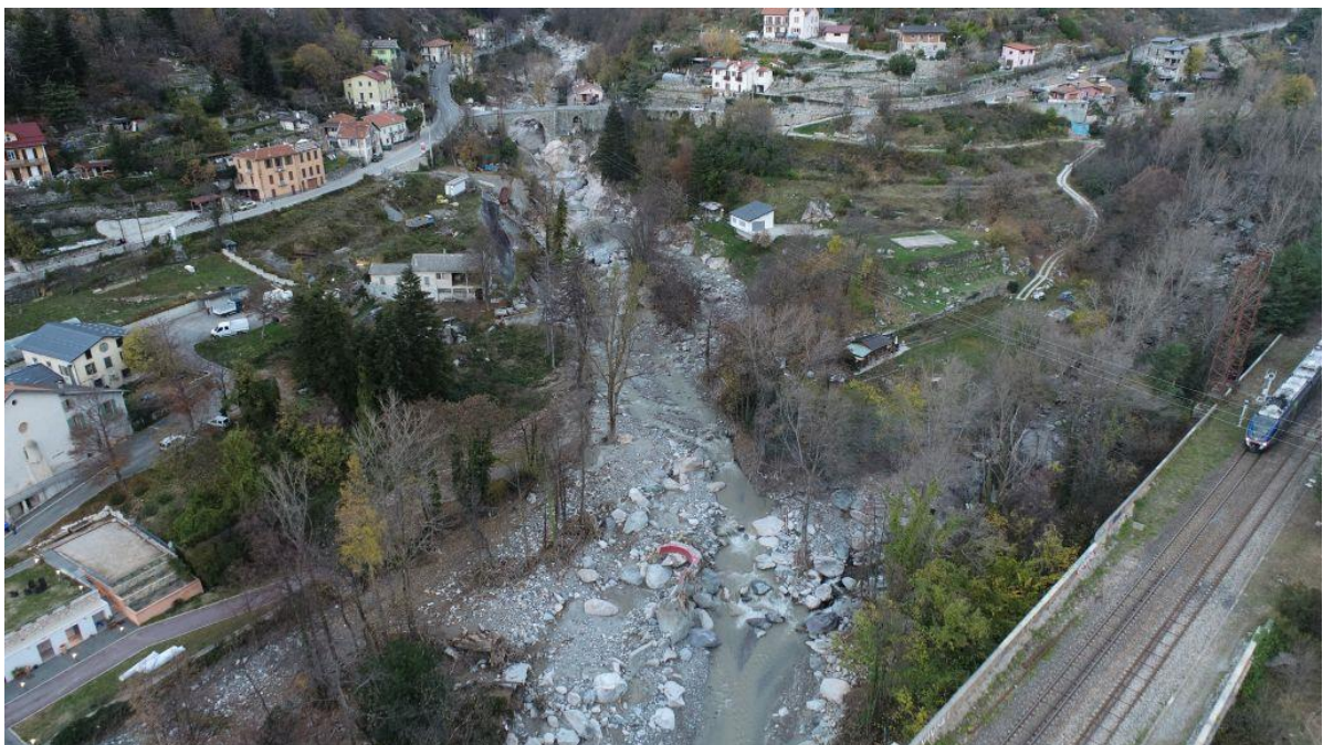
▲ Photo 42 : Amont viaduc voie ferrée au droit de la confluence avec la Levensa. Cliché : ONF-RTM Vue aval -> amont. Localisation : cf. Figure 94 ref. P1
