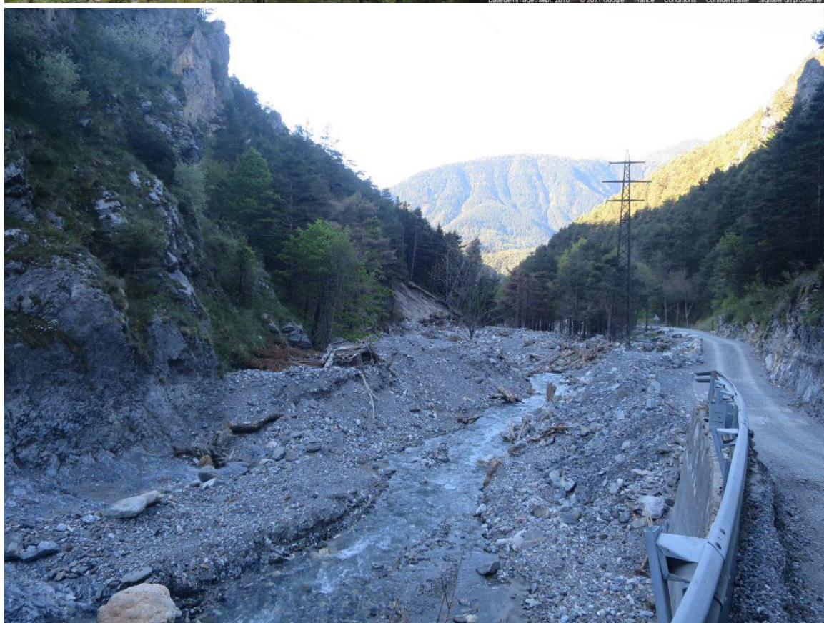
▲ Photo 19 (Haut) Photo 20 (bas) : Roya entre pont de Caramagne et musée Vallo Alpino (vue vers l'aval). Haut : 2010, source google Street View / Bas : 05/2021 après rétablissement de l'accès routier coupé, source ONF-RTM
