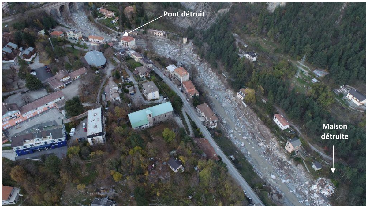
▲ Photo 49 : Lit de la Roya au droit de l'Eglise de St-Dalmas. Pont route Ste-Anne et maison d'habitation détruits. Vue aval -> amont. Cliché : ONF-RTM. Localisation : cf. Figure 94 réf. P6
