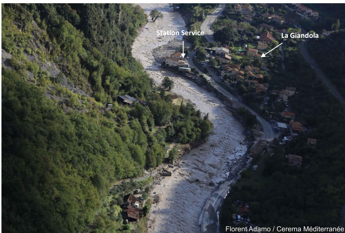
▲ Photo 87 : Roya au droit des hameaux du Canon et de la Giandola. Coupure de la route rive droite en amont de la Giandola. Affouillement des fondations du bâtiment de la station service. Vue amont -> aval. Cliché : F. ADAMO, CEREMA. Localisation : cf. Figure 104, ref. P5
