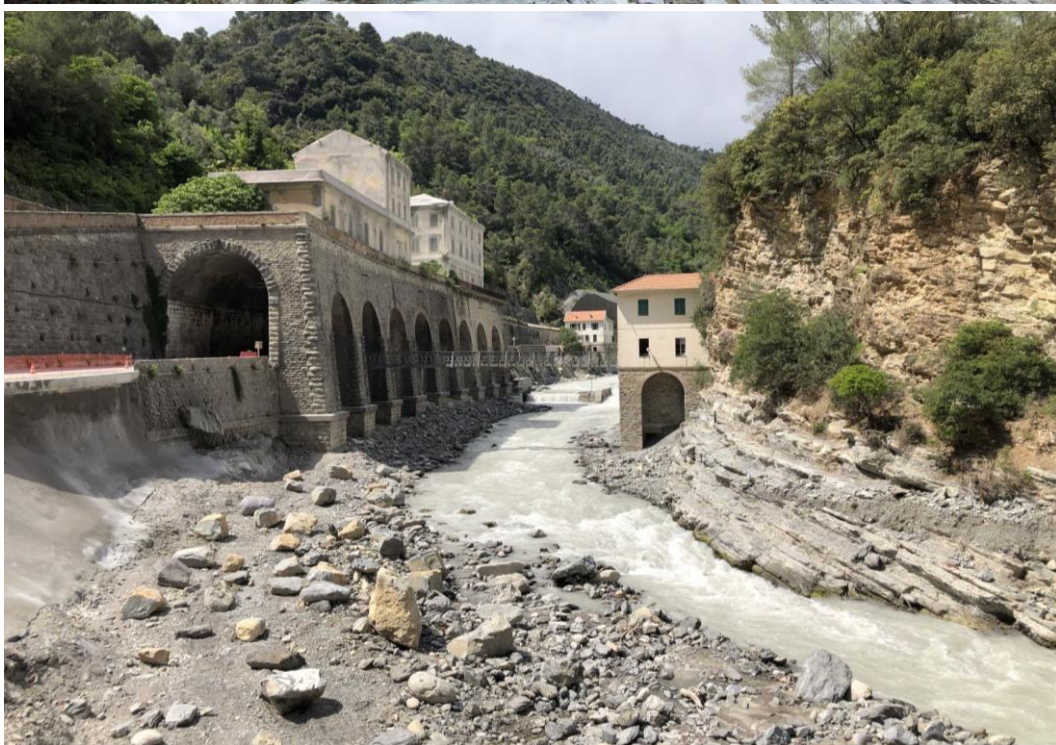
▲ Photo 97 (haut) et Photo 98 (bas) : Illustration de la remontée des niveaux au droit de Piene Basse (Passerelle et seuil EDF). Haut : cliché 2007, source AD06 / Bas : cliché 06/2021, source ONF-RTM
