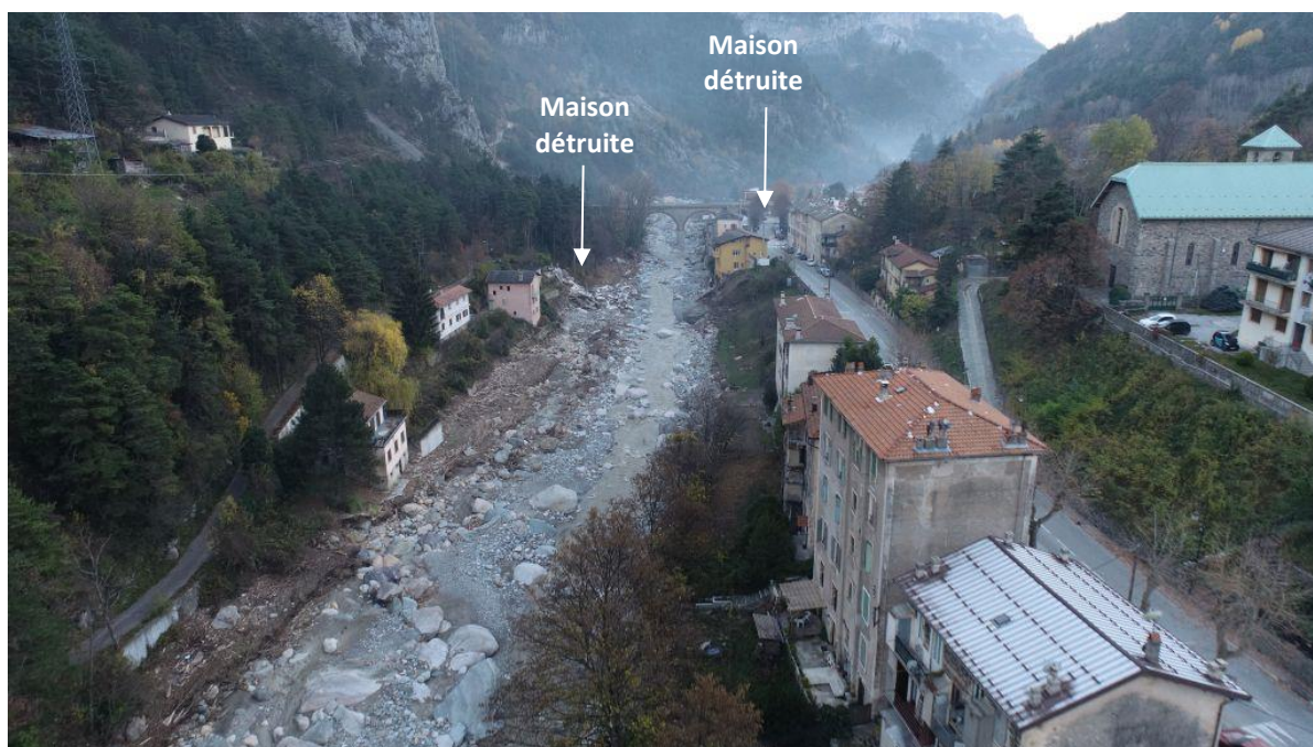
▲ Photo 46 : Lit de la Roya au droit de l'Eglise de St-Dalmas. 2 maisons détruites. Vue amont -> aval Cliché : ONF-RTM . Localisation : cf. Figure 94 ref. P3
