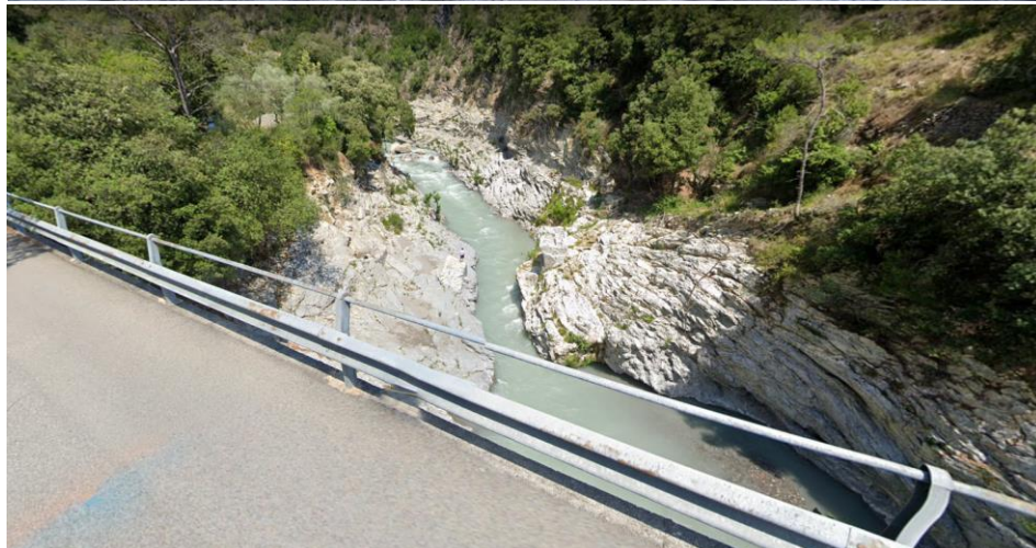
▲ Photo 101 (haut) et Photo 102 (milieu) Photo 103 (bas) : Illustration de la remontée des niveaux au droit du pont Fanghetto Haut : google street view 2011 / Milieu : pendant la crue source internet https://www.facebook.com/EmissionLaPlaceDuVillage/photos/pcb.1756186747880700/1756185154547526/?type=3&theater / Bas : google street view 07/2021
