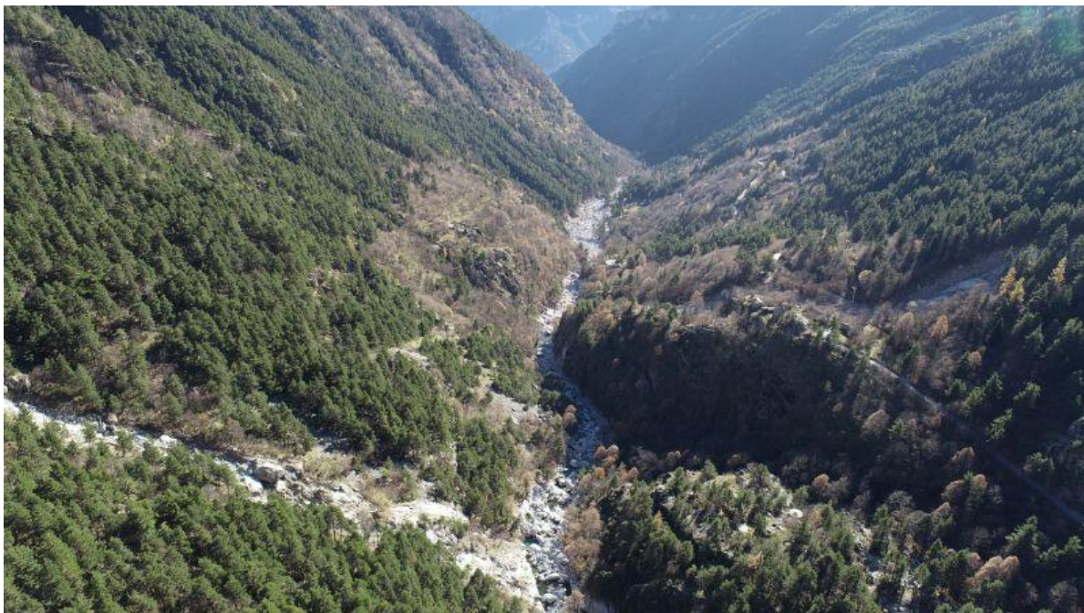
▲ Photo 52 : Lit de la Bieugne en aval du barrage des Mesches. Vue amont -> aval Cliché : ONF-RTM.
