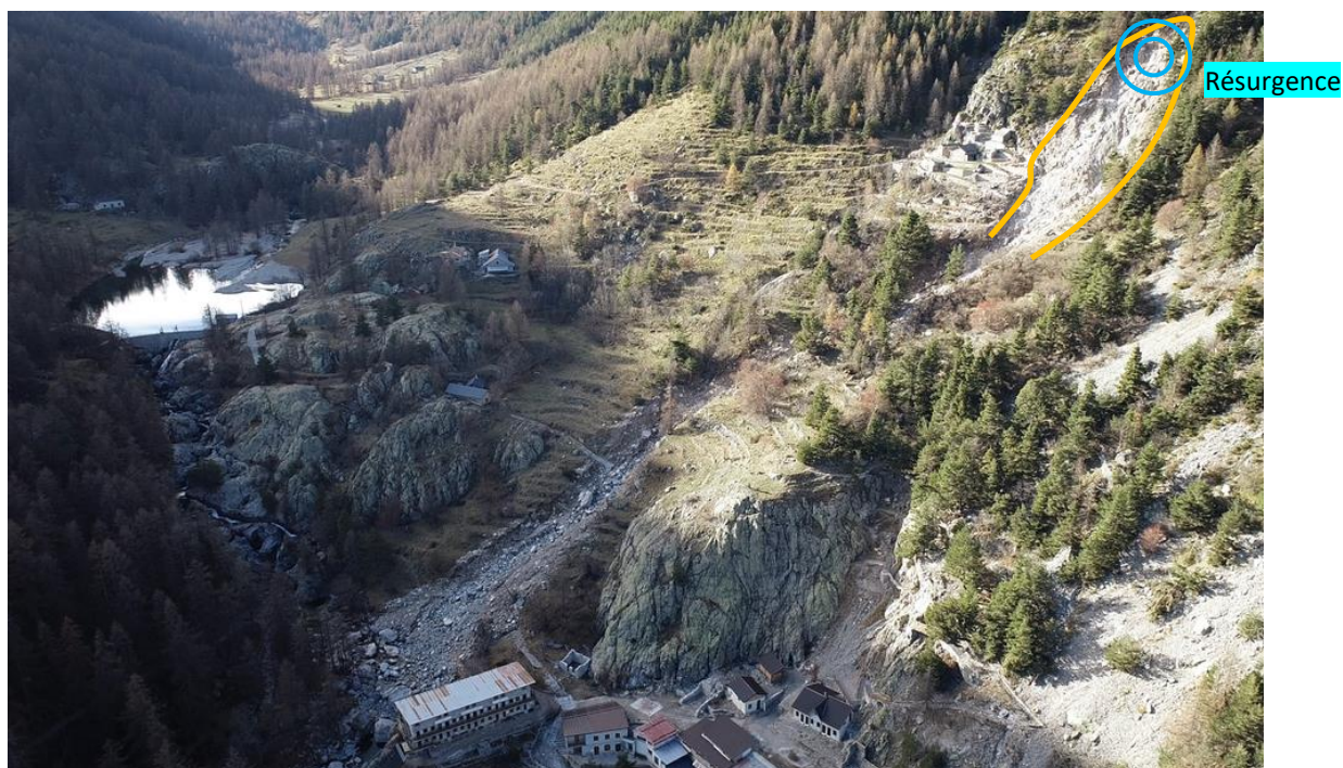
Figure 57 : Talweg torrentiel en amont de Vallauria (Source : ONF-RTM, 17-18/11/2020)
