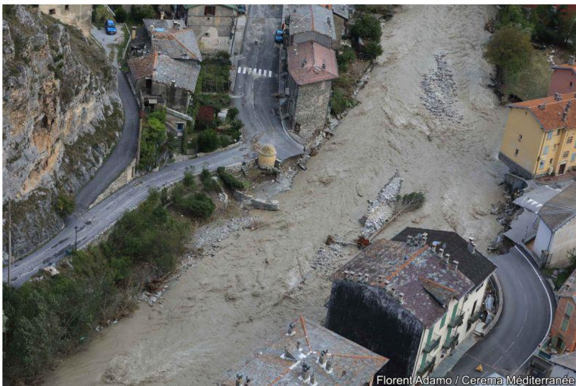
▲ Photo 37 : Destruction du pont av. Georges Bidault et de 3 bâtiments en amont du pont Cliché : F. ADAMO, CEREMA. Localisation : cf. Figure 86, réf. P8
