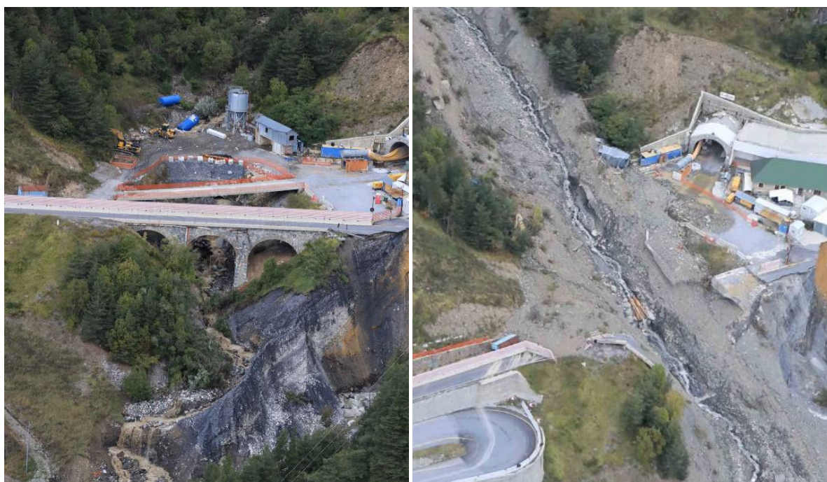
Figure 38 : A gauche, vallon de la Ca avant déclenchement du glissement de terrain (03/10/2020) ; à droite après le glissement de terrain (09/10/2020) (Source : F. Adamo, CEREMA)
