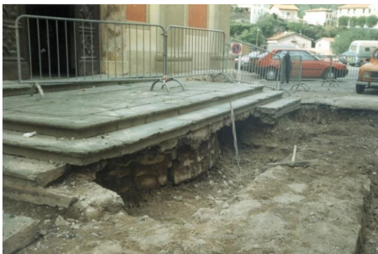
Figure 5. Vestiges d'absides de l'église médiévale, mis à jours sous le parvis, lors des travaux de réfection des canalisations sur la place en 1994. (Auteur du cliché non identifié)
