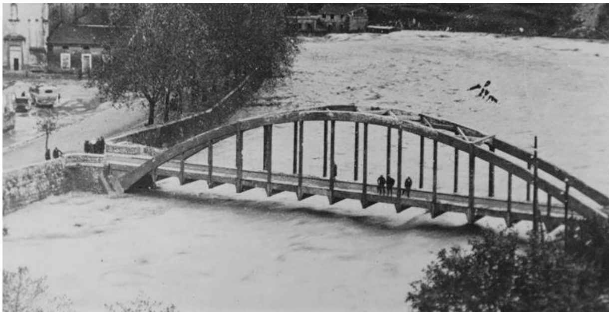
Figure 19. Vue du pont Charabot initial.
