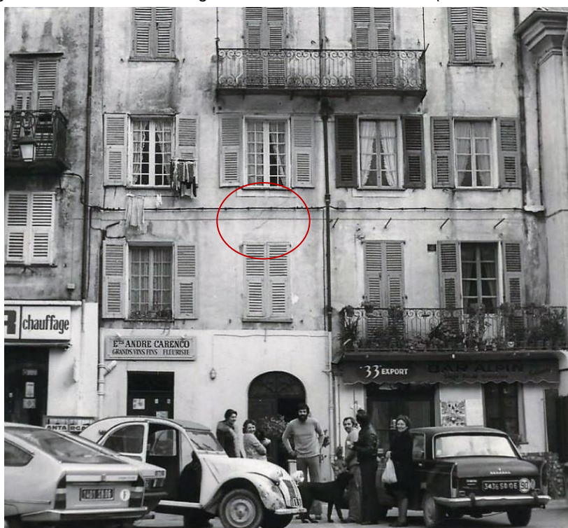
Figure 59. Vue de la façade vers 1970. On observe une seule fissuration d'allège. (Source non identifiée)
