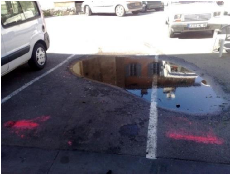
Figure 51. Photos de la flaque sur la fuite, face au nord du presbytère, sur les canalisations changées en 1994, et dont la réparation n'a été entreprise qu'après plusieurs mois. a) 4 septembre 2010 ; b) 24 mars 2011 ; c) 19 avril 2011. (Clichés V. Pignot)
