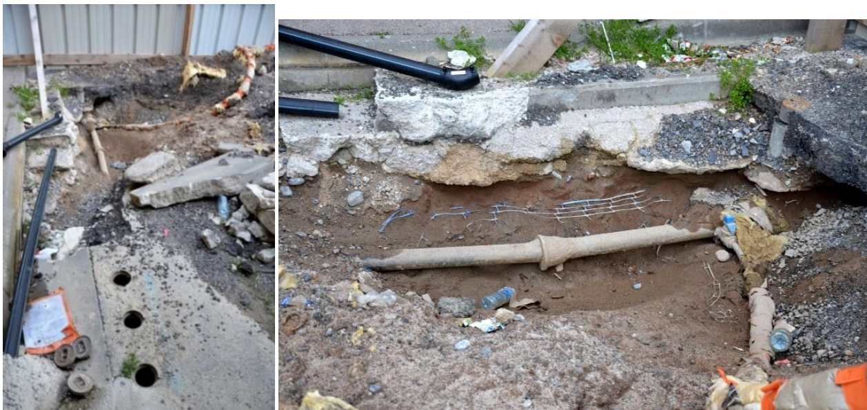
Figure 61 et Figure 62. Vues le 10 avril 2013, de la canalisation mise à jour près du surcreusement devant la « maison Gambaraza » (parcelle E 167). (clichés P. Balandier)
