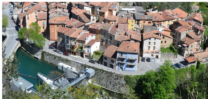
Vue d'ensemble de la rue Marius Cauvin, du pont Inférieur au nord, place Cellier à la place Rousse au Sud.
