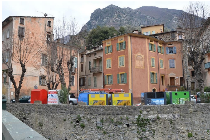
Vue de la place Cellier, au départ nord de la rue Marius Cauvin, depuis le pont Inférieur, entrée Sud de Breil.
