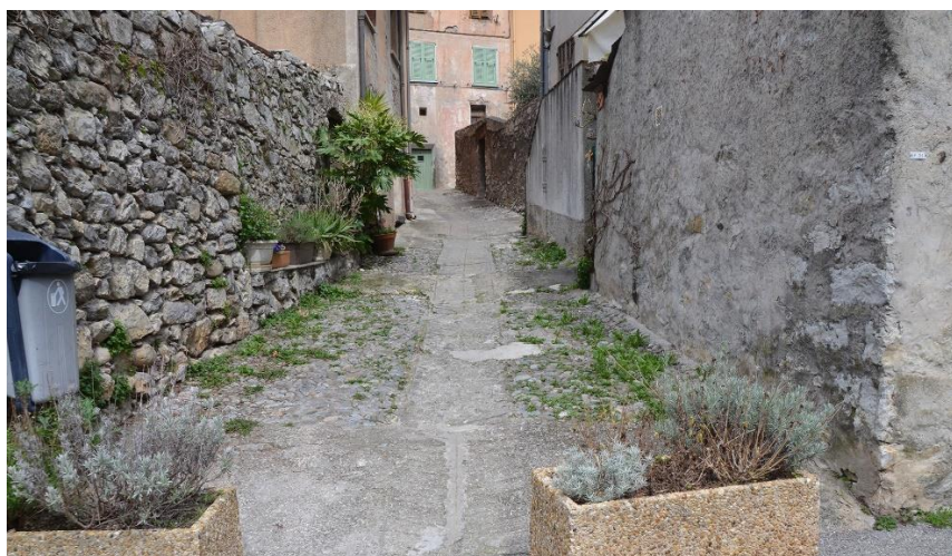
Ruelle / coureou d'A Stacada reliant la rue Marius Cauvin et la rue Place Rousse, avec une pente relativement modérée, qui mériterait un traitement de sol facilitant le déplacement des fauteuils roulants et des poussettes.
