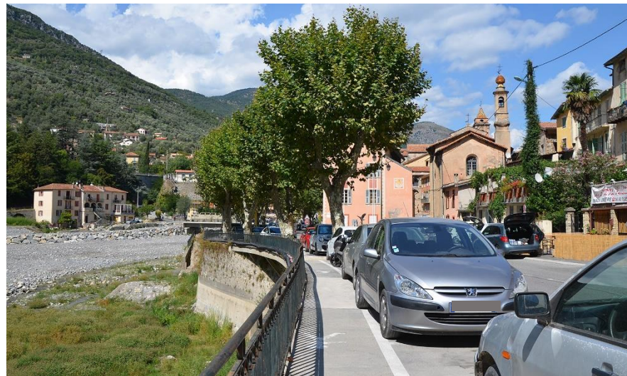
Vue du stationnement sur le trottoir de la partie sud du boulevard Rouvier, et de la bande réservée aux piétons, fin août 2021.
