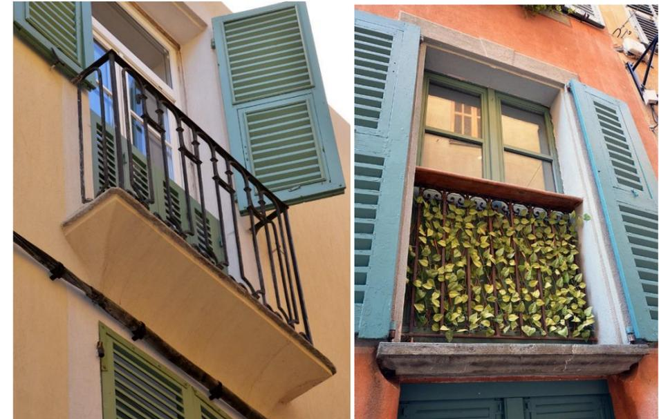
A partir du XIXe siècle, on trouve des balcons en dalles de schiste de Tende, portées par des consoles triangulées en fer forgé, plus ou moins ornementées. Certains balcons en dalle minérale furent plus tard portés par des profilés simples plus largement dimensionnés, mieux ancrés dans le mur, et non triangulés.
