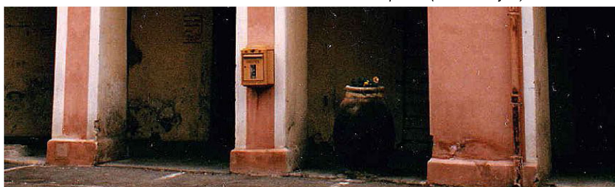
Vue en mai 1994. La place a été remontée de 15-20 cm, et arrive désormais au niveau du sol sous les arcades. (Cliché P. Balandier)
