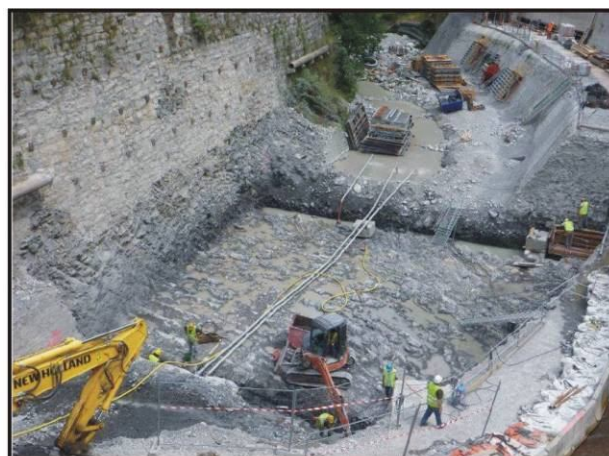
Fond de fouille, 25/06/2013 (270,5 m NGF) (in Hydrostadium, nov. 2013)
