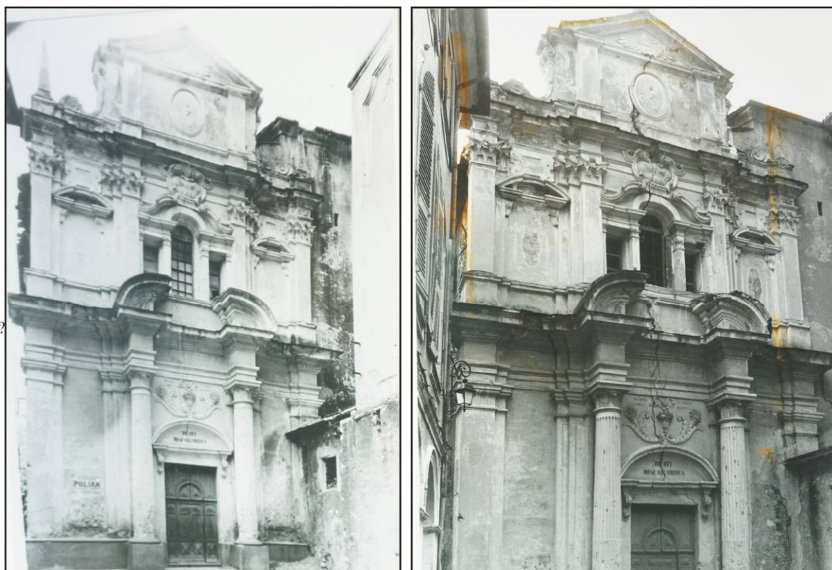
1948 1978 Façade orientale de la chapelle de la Miséricorde en 1948 et en 1978, illustrant l'ouverture de la fissure principale en 30 ans (photographies, in Yarmola , 1978)
