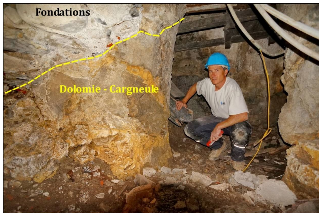
Affleurement de dolomies/cargneules du Keuper sous l'ancien moulin Cacciardi/église Santa Maria In Albis (cliché H2EA, 2014)
