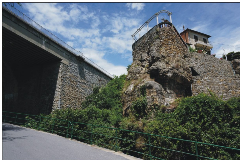
Piton rocheux (dolomie, cargneules, calcaires à laminites) à l'Est du pont SNCF sur la Lavina (cliché H2EA, 2014)
