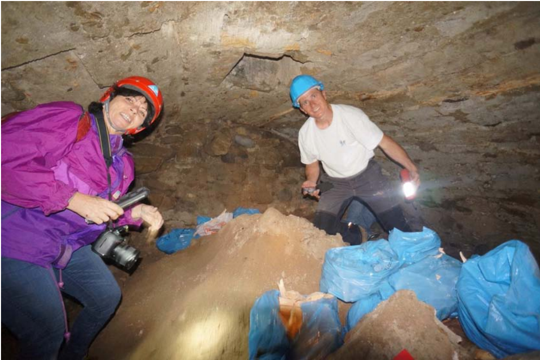
Crypte remblayée quasiment jusqu'à la voûte. Des ossements humains sont rassemblés dans des sacs bleus et déposés sur le remblai. L'accès aux anciens canaux est désormais impossible. Vue vers l'Ouest.
