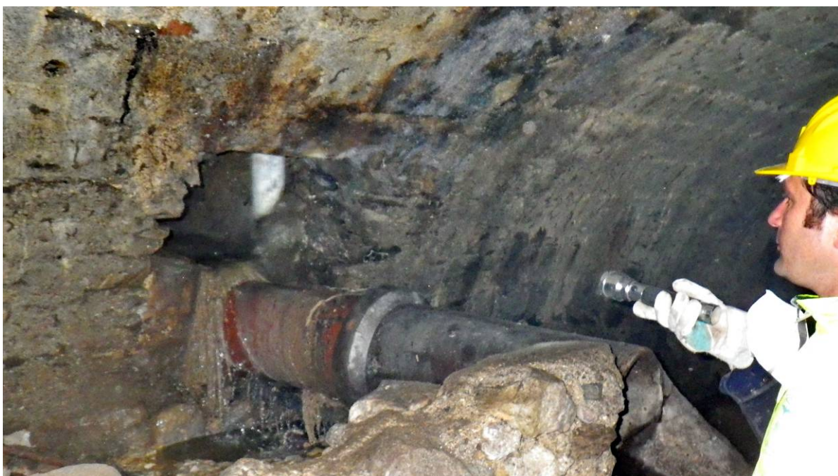
Cette galerie récupère une partie des EU de la rue Pasteur et des eaux pluviales de gouttières Vue ver l'Est
