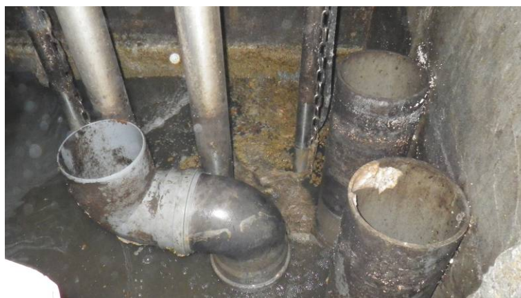
Noter les surverses vers ancien réseau EU Vue vers le Sud
