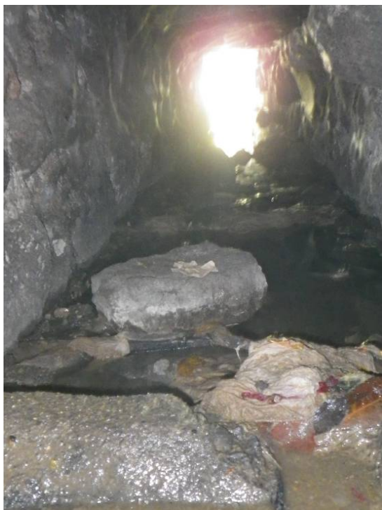
Vue sur galerie vers lac (quelques cm au dessus de la cote du lac) Cette galerie sert de surverse au effluents EU Vue vers l'Ouest
