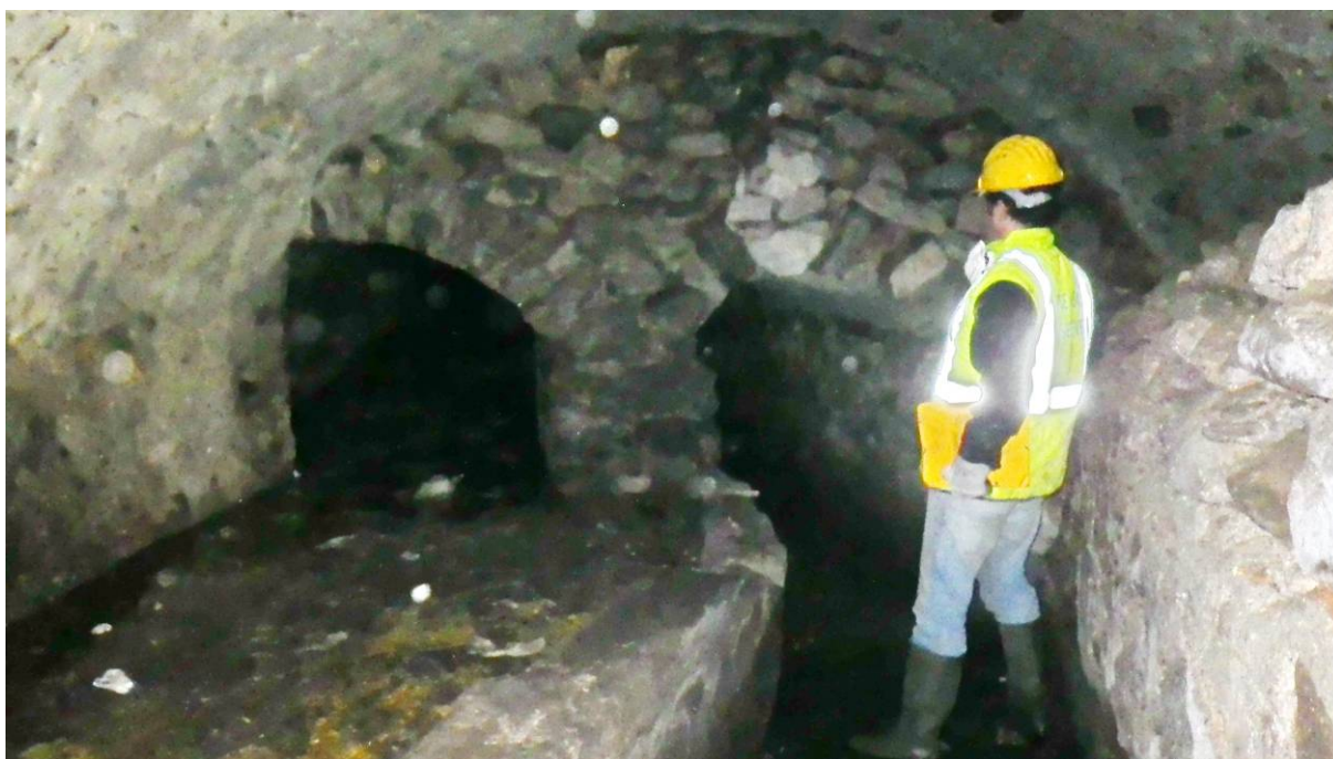
Canal Toesca (à gauche) et canal Boéri (à droite). Le radier du canal Toesca est plus haut que celui de Boéri Vue vers le Sud
