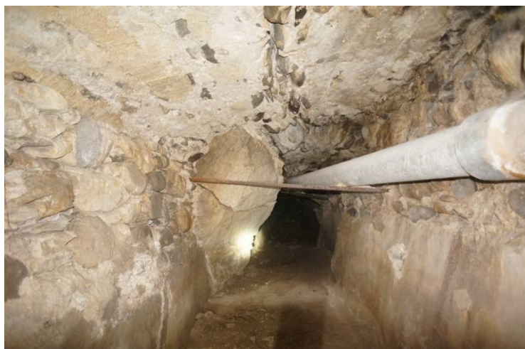
L = 1,4 m H = 1,5 m Vues vers le Sud-Ouest
