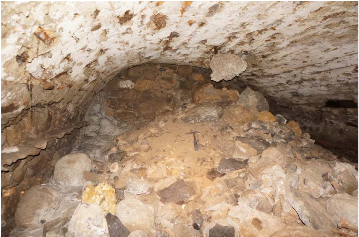
Remblaiement et épanchement de béton dans l'angle nord-est. Vue vers l'Est
