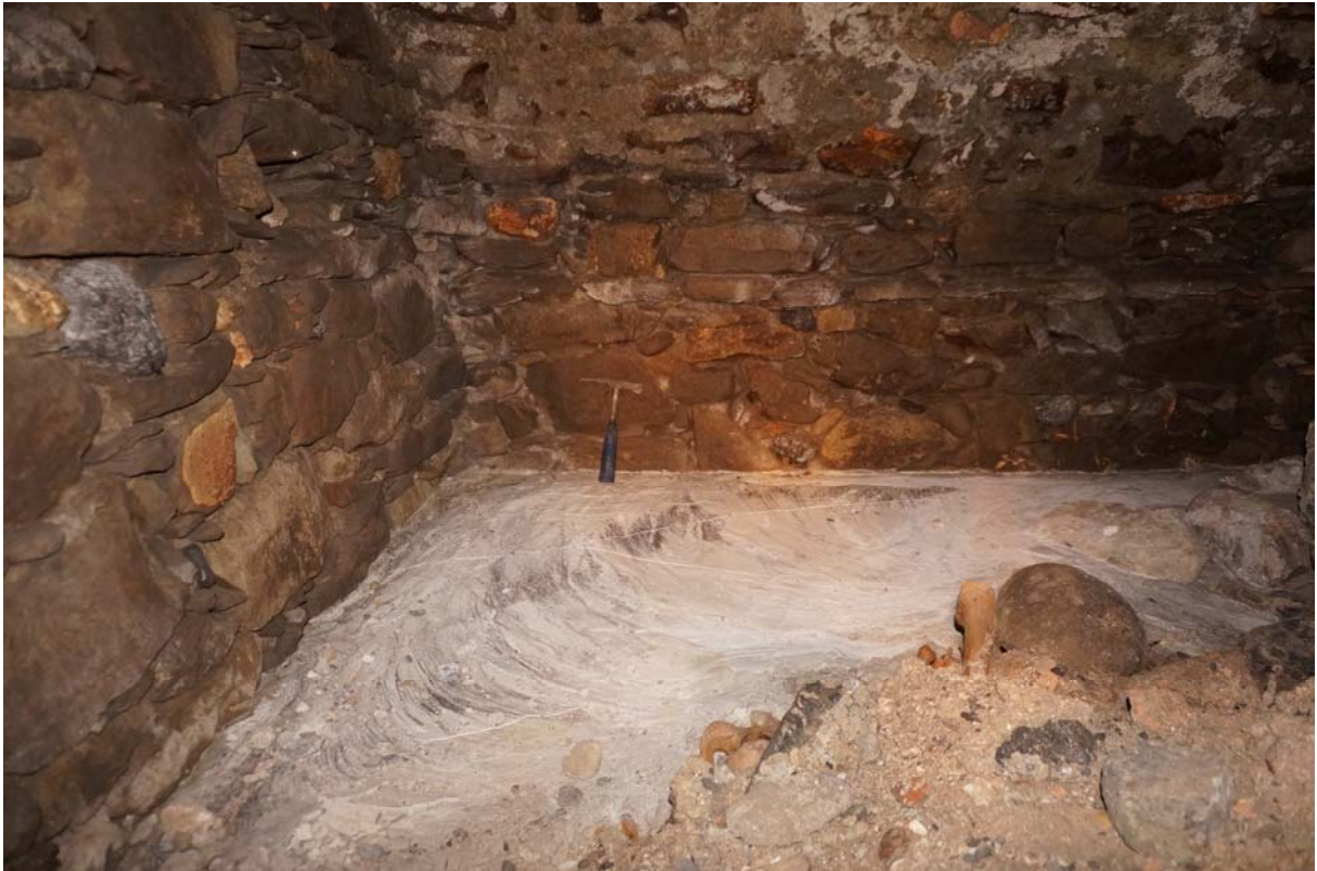
Crypte remblayée, plus d'accès à la galerie nord-sud sous l'église Santa Maria et la chapelle Epanchement de béton dans l'angle nord-ouest Vue vers le Nord
