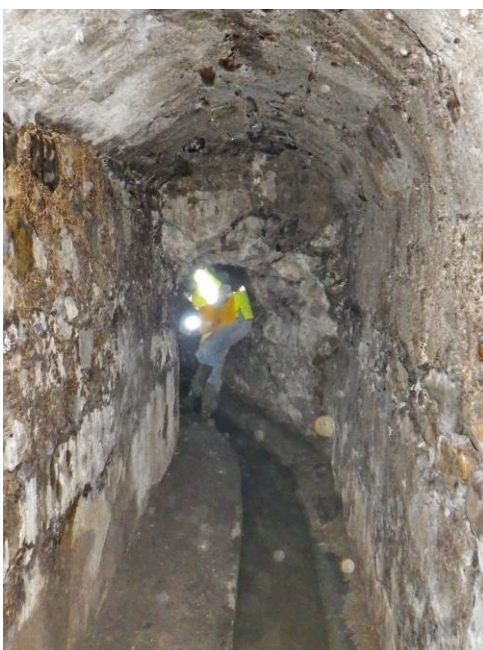
La galerie passe sous les fondations de l'ancienne passerelle Charabot (mur 1,3m) Vue vers le Sud-Ouest
