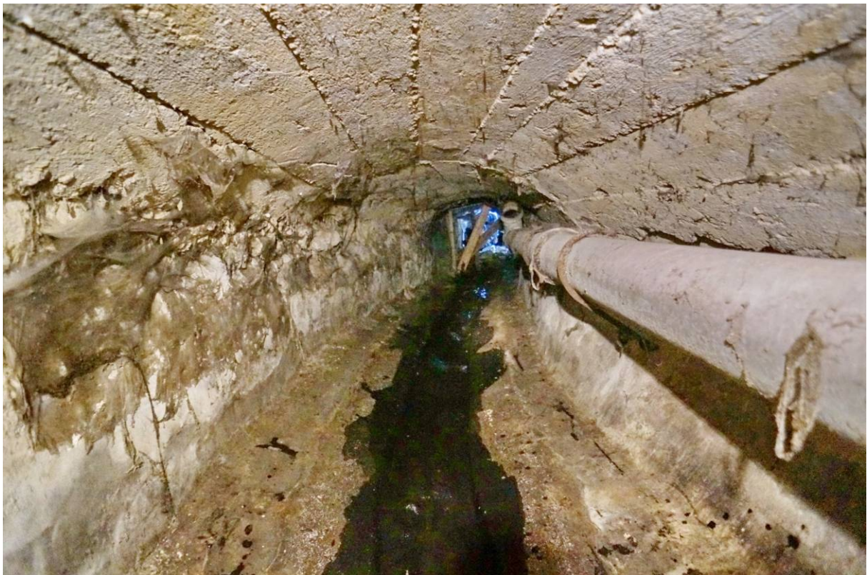
Tronçon de canal sous l'angle Nord-Ouest du bâtiment Guidi. Voûte partiellement reprise à une époque antérieure. L= 1,3 m, H= 0,85 m Vue vers le Sud-Ouest.
